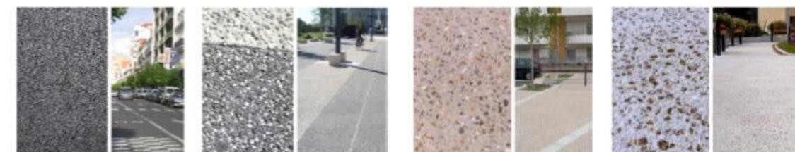
Figure 67 : Enrobé, enrobé grenailé, béton beige bouchardé et béton gris bouchardé
