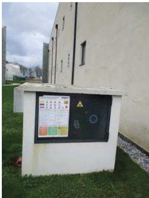
Dépotage des cuves enterrées alimentant les groupes électrogènes présents dans bâtiment DC08
