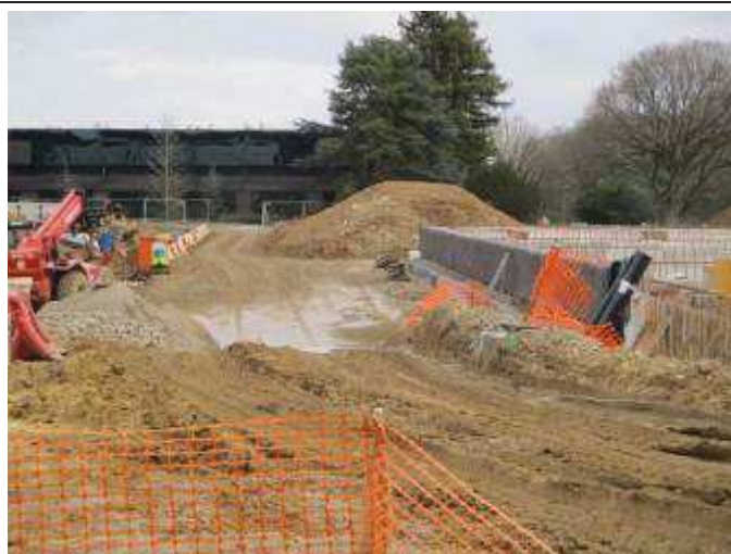
Zone de travaux pour la construction des futurs bâtiments DC09 et DC10.
