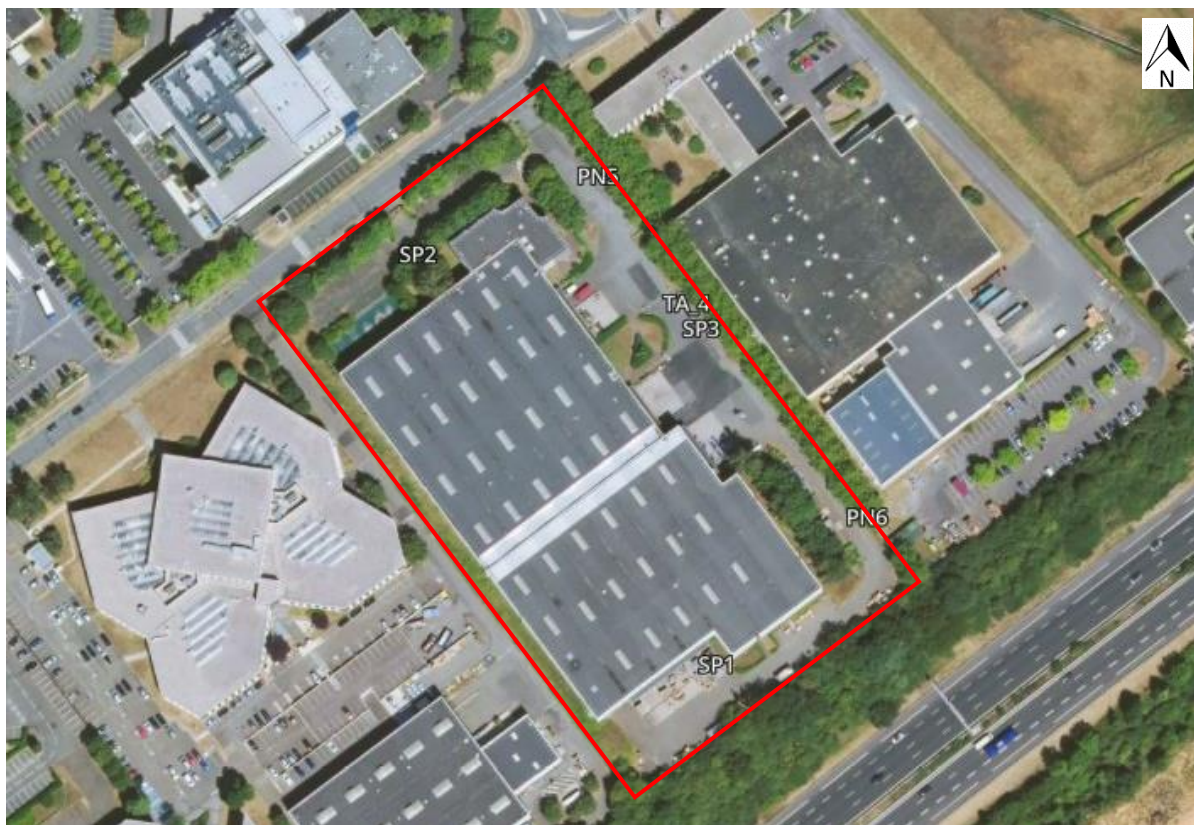
Figure 46 : Localisation des sondages – FONDASOL en 2021
