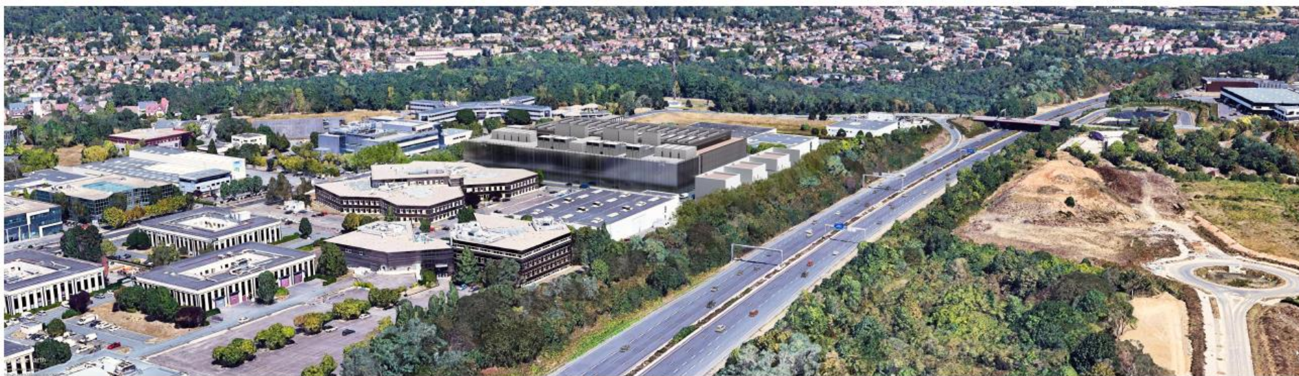
Figure 140 : Vue aérienne de l'intégration visuelle du projet – Sud
