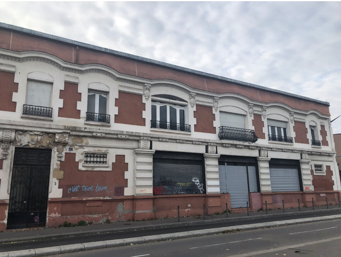
Vue de la façade principale depuis le quai de la Gironde
