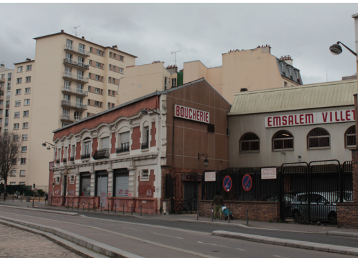
Vue du bâtiment C
