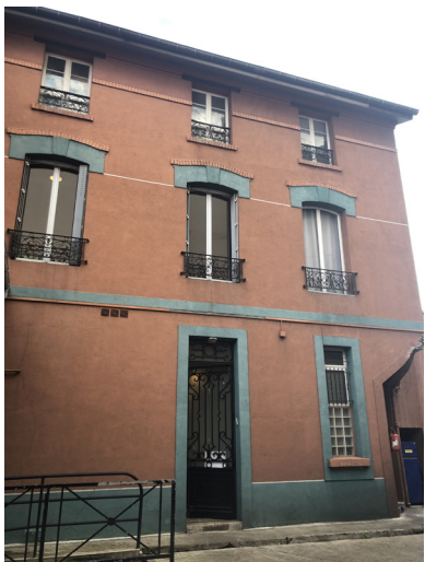
Détails architecturaux bâtiment C
