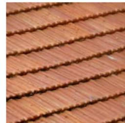
Couverture en tuiles mécaniques en terre cuite ton rouge-orangé
