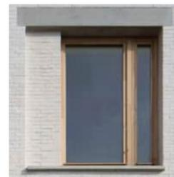
Menuiseries en bois ton naturel avec appui de fenêtre maçonné
