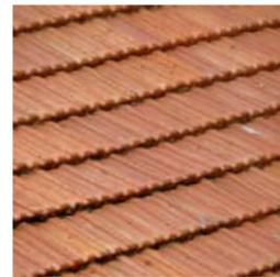
Couverture des sheds en tuiles mécaniques en terre cuite ton rouge-orangé
