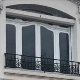
Ferronneries existantes peintes en noir Menuiseries en bois peintes en blanc
