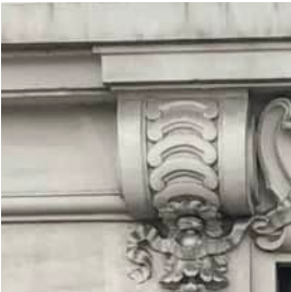
Enduit sur maçonnerie peint ton rouge sombre Enduit sur modénatures peint ton crème
