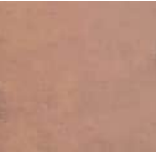
Enduit sur maçonnerie peint ton rouge sombre cour intérieure
