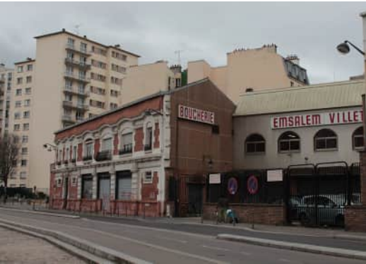
Vue du bâtiment C
