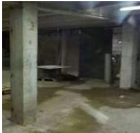
LOCALISATION DU SONDAGE N°C11
