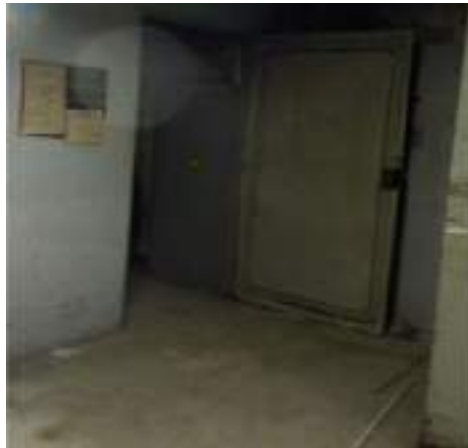
LOCALISATION DU SONDAGE N°C12
