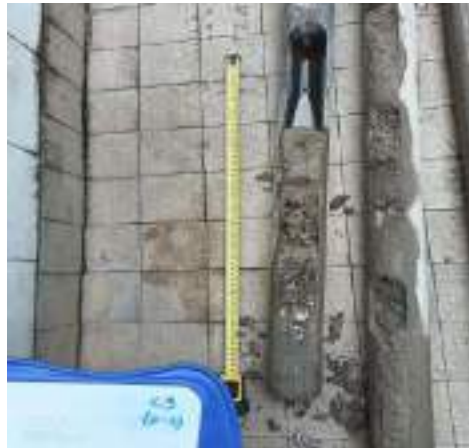
LOCALISATION DU SONDAGE N°C9
