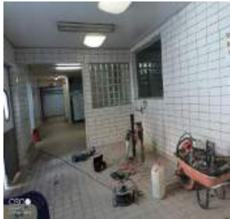
LOCALISATION DU SONDAGE N°C5
