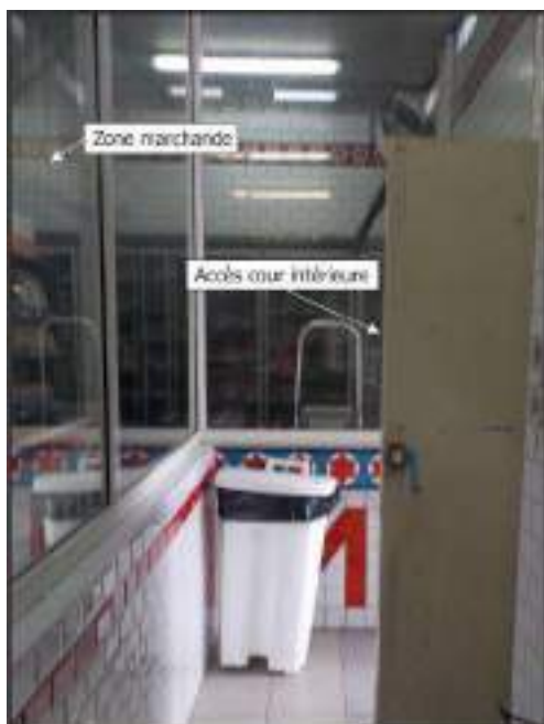
Photographie 32 : Vue sur l'accès à la cour intérieure
