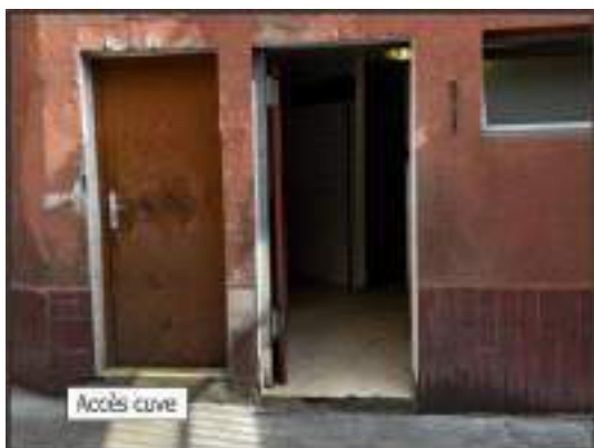
Photographie 30 : Vue sur l'accès à la cuve
