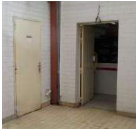
LOCALISATION DU SONDAGE N°C9
