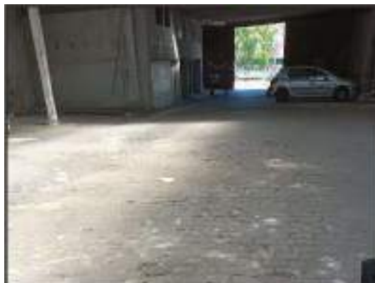
Photographie 22 : Vue sur le parking (ancienne tannerie / garage)
