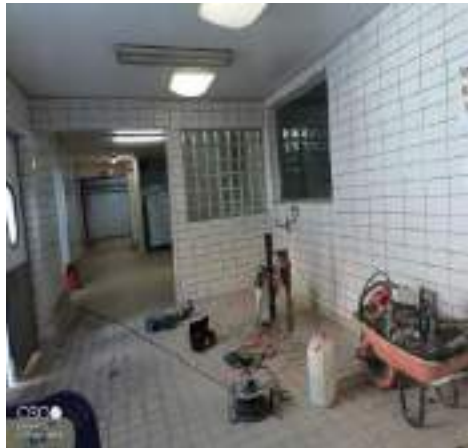
LOCALISATION DU SONDAGE N°C5
