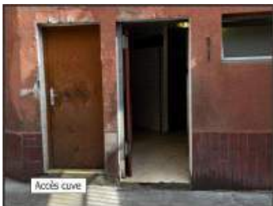
Photographie 30 : Vue sur l'accès à la cuve
