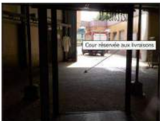
Photographie 27 : Vue sur la cour réservée aux livraisons
