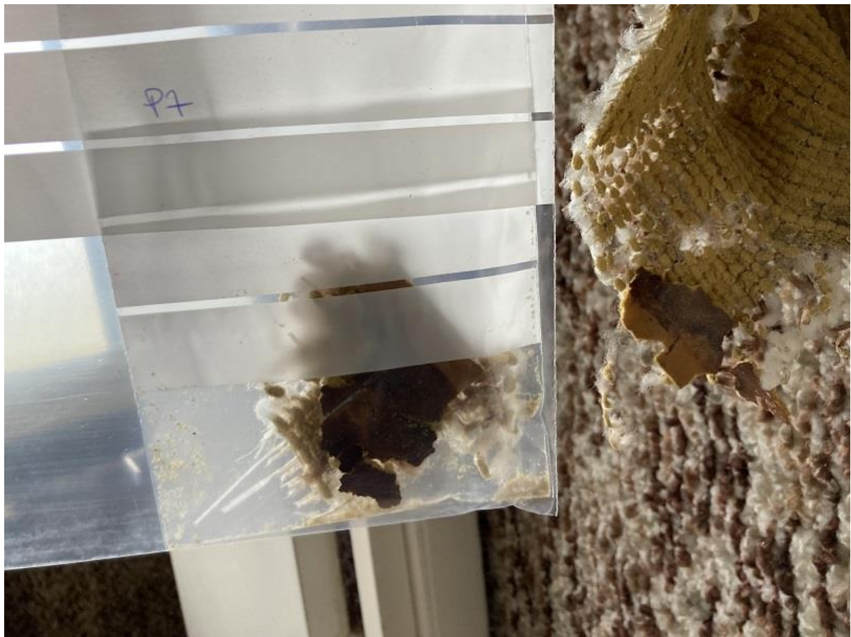
Prélèvement n°7 : Pas de fibres d'amiante détectées après analyse en laboratoire.
