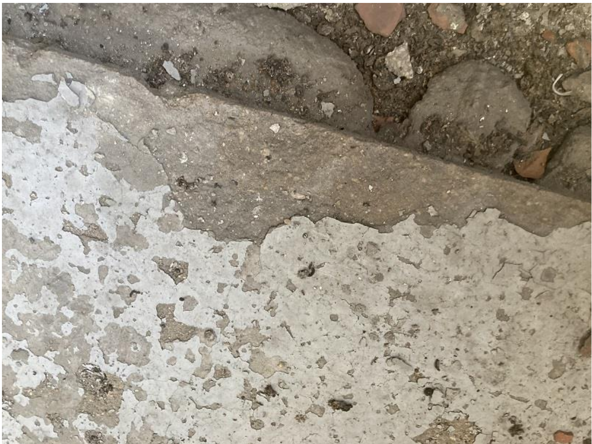
Prélèvement n°72 : Pas de fibres d'amiante détectées après analyse en laboratoire.
