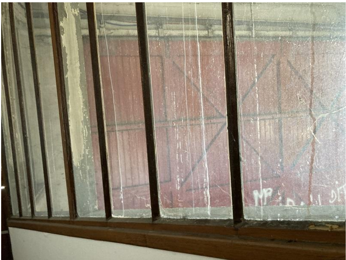
Prélèvement n°44 : Pas de fibres d'amiante détectées après analyse en laboratoire.
