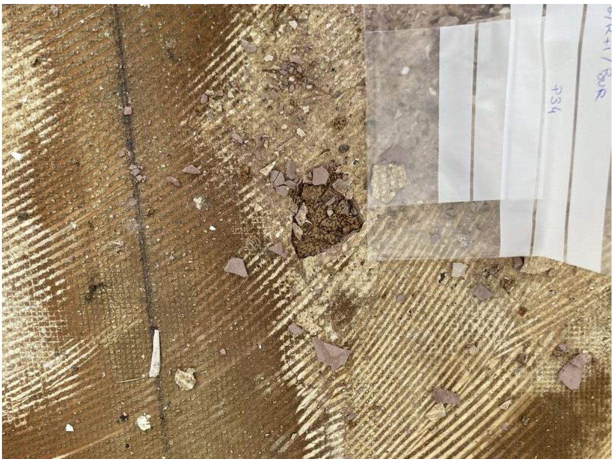
Prélèvement n°34 : Pas de fibres d'amiante détectées après analyse en laboratoire.
