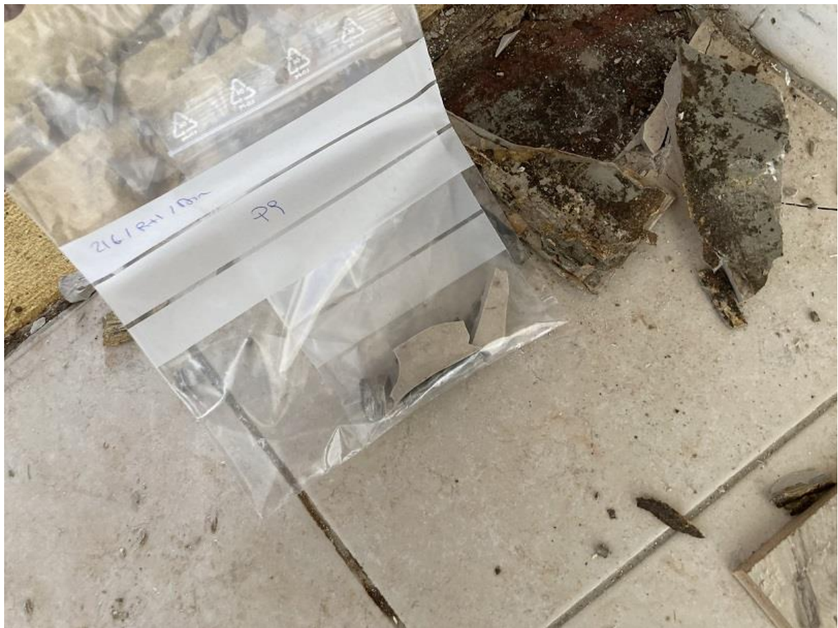
Prélèvement n°9 : Pas de fibres d'amiante détectées après analyse en laboratoire.
