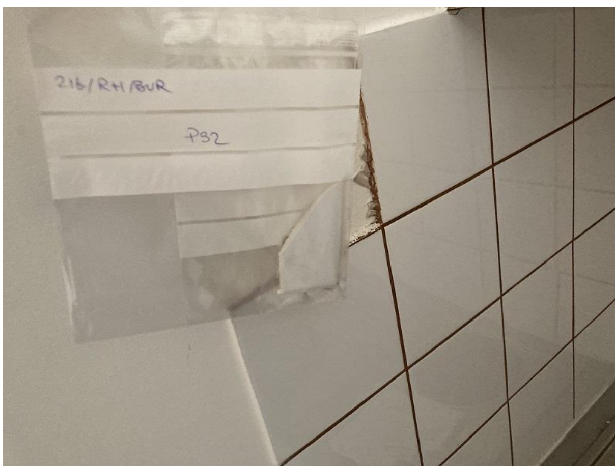
Prélèvement n°32 : Pas de fibres d'amiante détectées après analyse en laboratoire.
