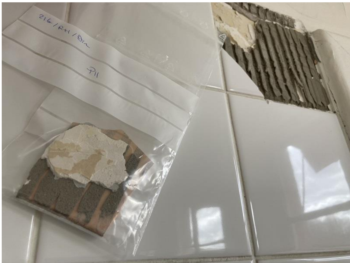
Prélèvement n°11 : Pas de fibres d'amiante détectées après analyse en laboratoire.
