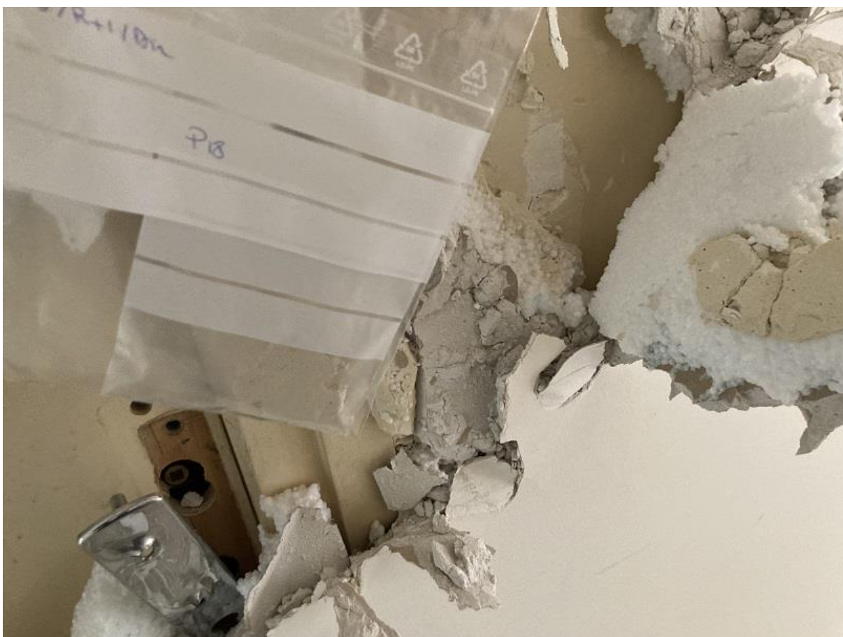
Prélèvement n°18 : Pas de fibres d'amiante détectées après analyse en laboratoire.
