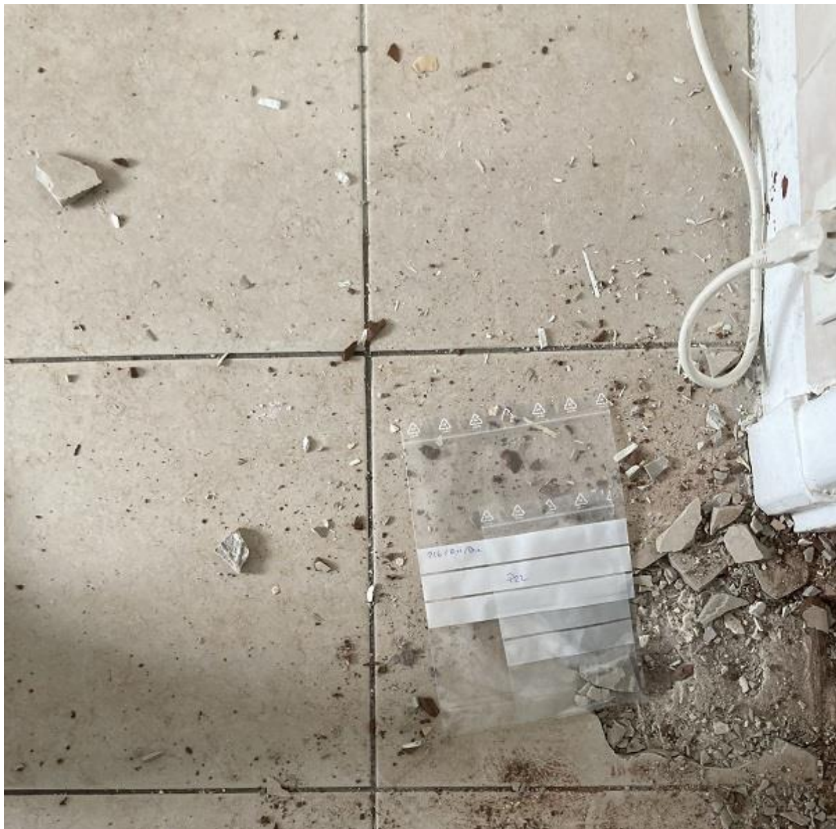
Prélèvement n°22 : Pas de fibres d'amiante détectées après analyse en laboratoire.
