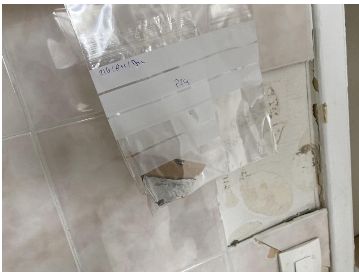
Prélèvement n°24 : Pas de fibres d'amiante détectées après analyse en laboratoire.
