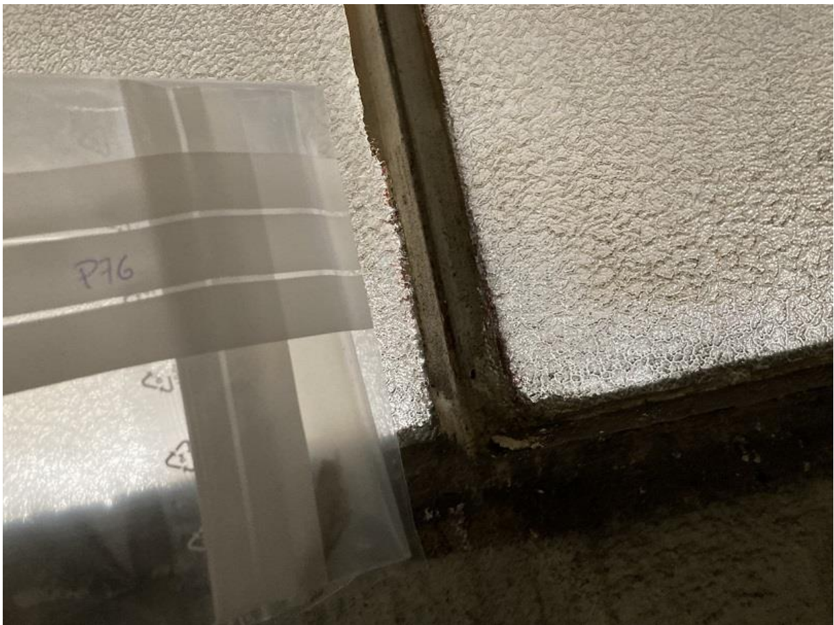
Prélèvement n°76 : Pas de fibres d'amiante détectées après analyse en laboratoire.
