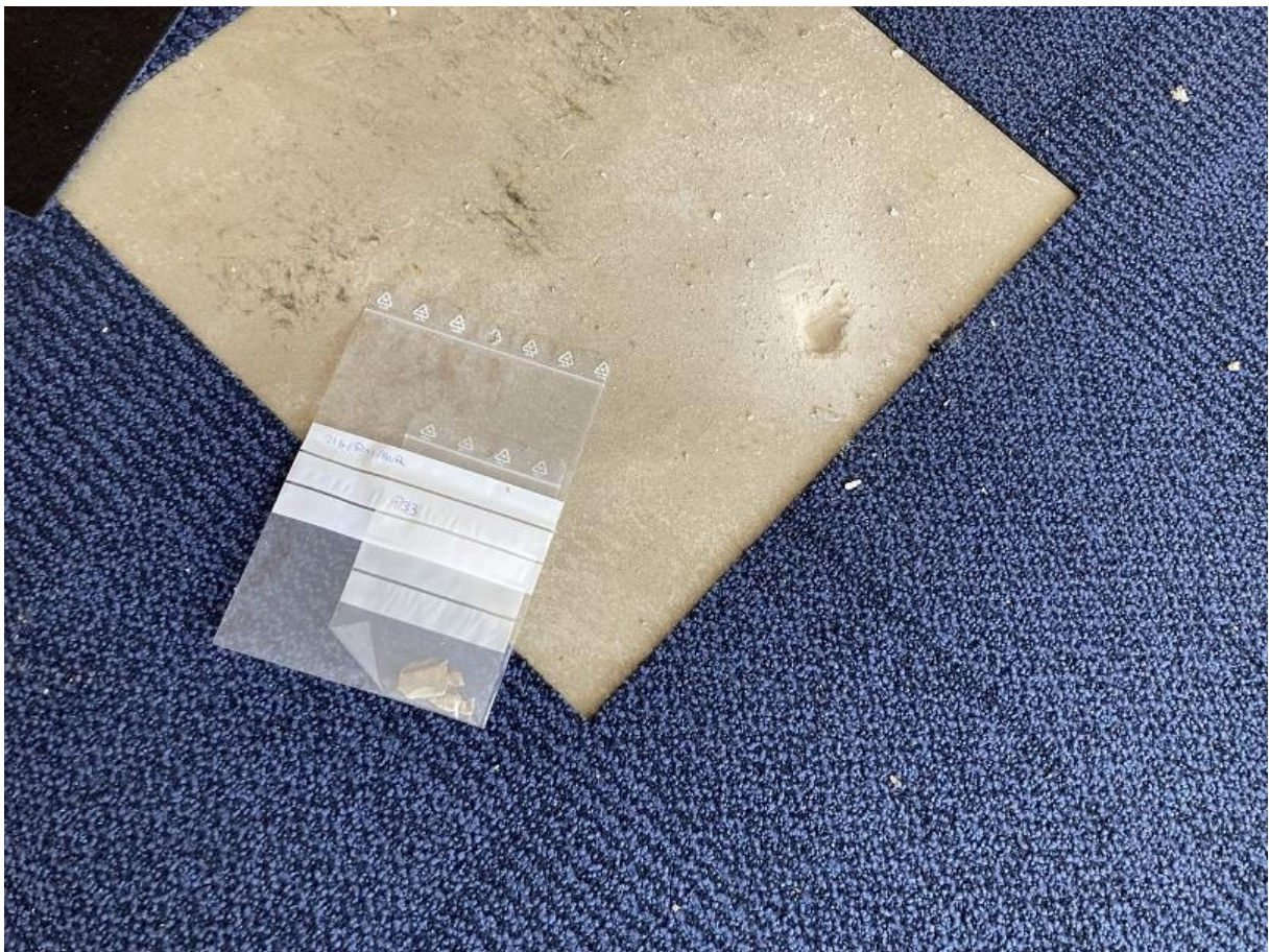
Prélèvement n°33 : Pas de fibres d'amiante détectées après analyse en laboratoire.
