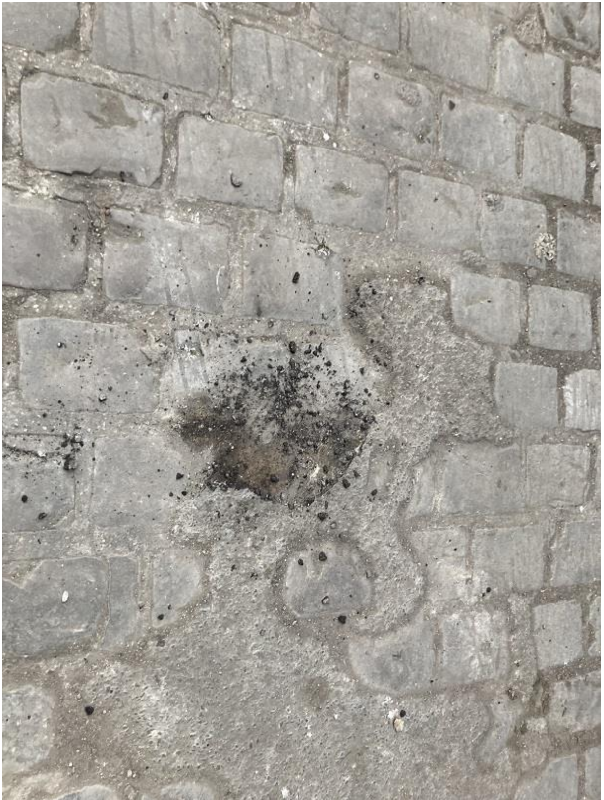
Prélèvement n°82 : Pas de fibres d'amiante détectées après analyse en laboratoire.
