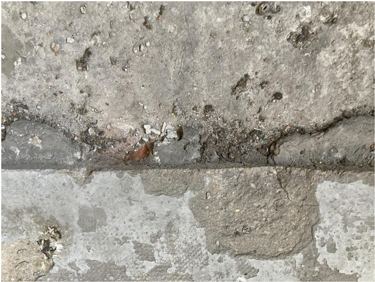
Prélèvement n°71 : Pas de fibres d'amiante détectées après analyse en laboratoire.
