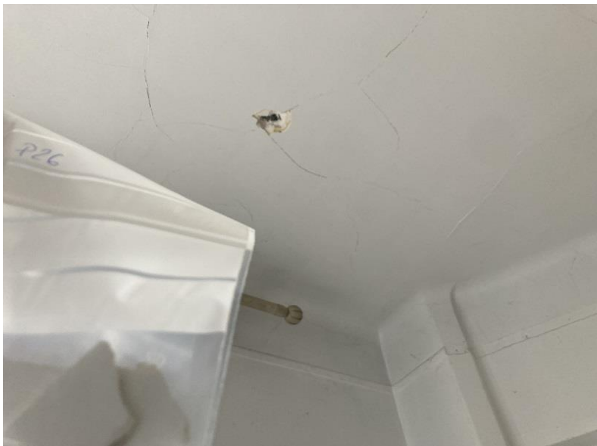
Prélèvement n°26 : Pas de fibres d'amiante détectées après analyse en laboratoire.
