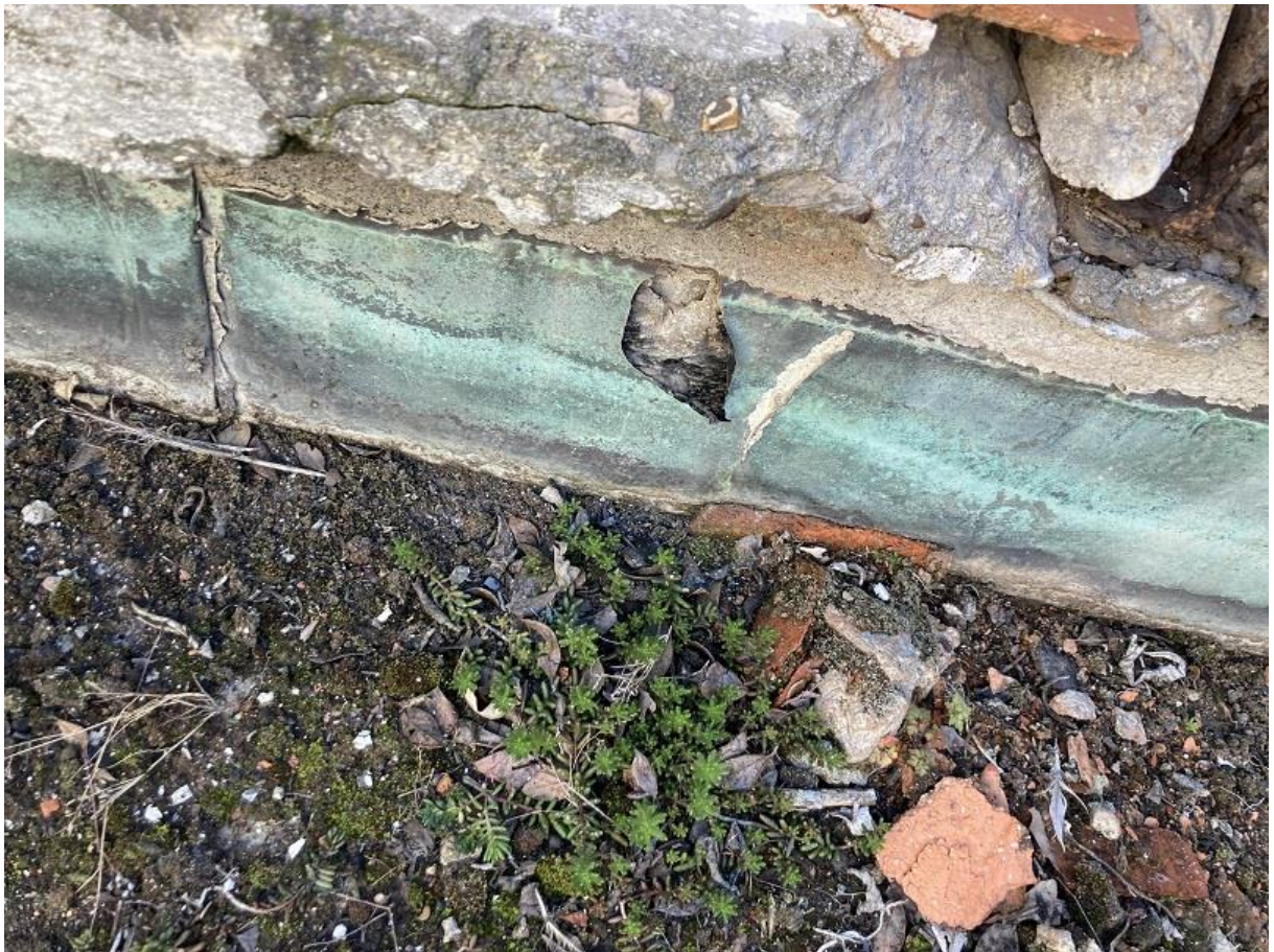
Prélèvement n°55 : Pas de fibres d'amiante détectées après analyse en laboratoire.
