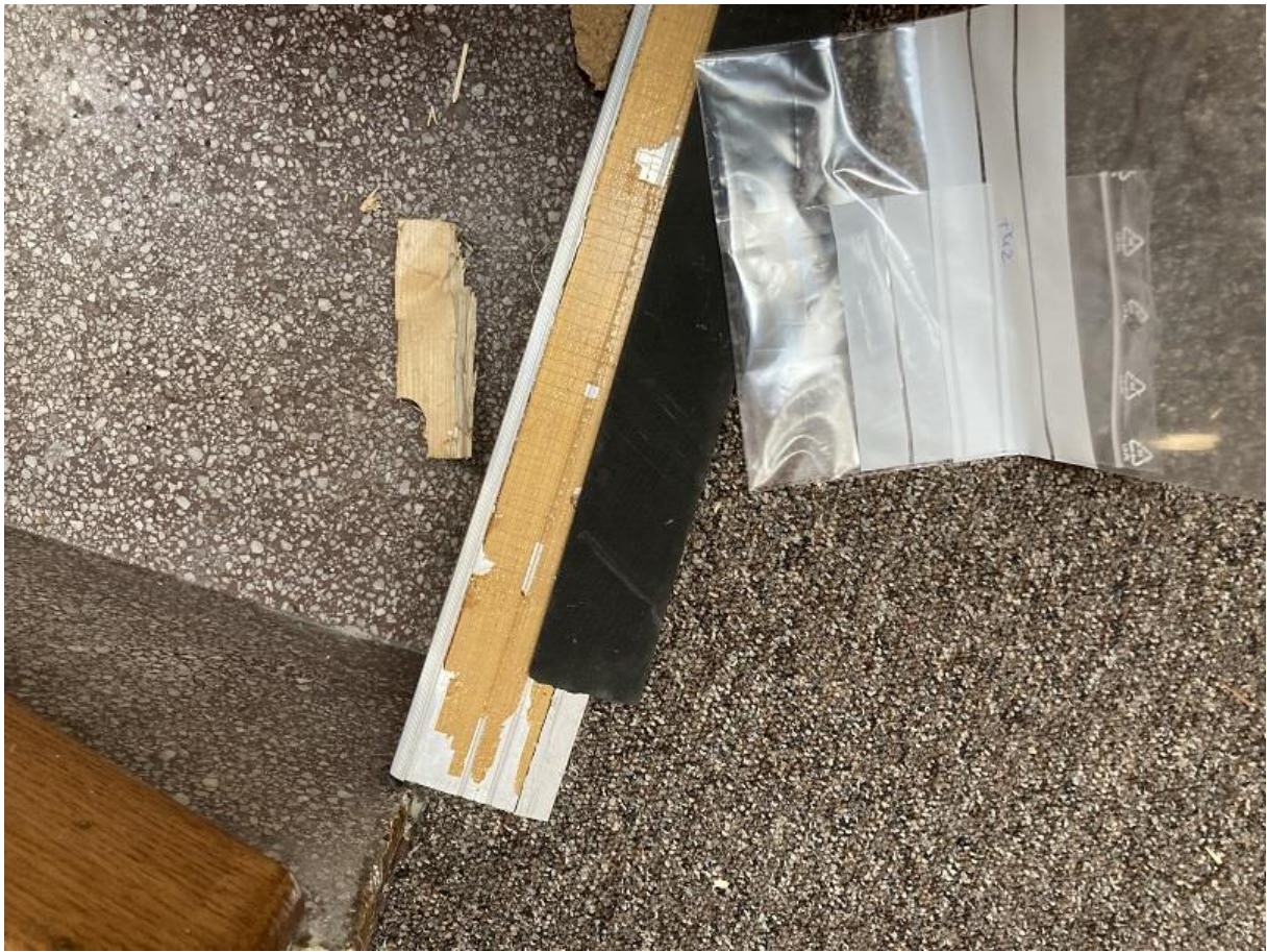
Prélèvement n°42 : Pas de fibres d'amiante détectées après analyse en laboratoire.
