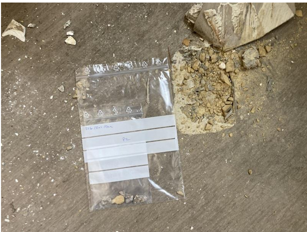
Prélèvement n°2 : Pas de fibres d'amiante détectées après analyse en laboratoire.
