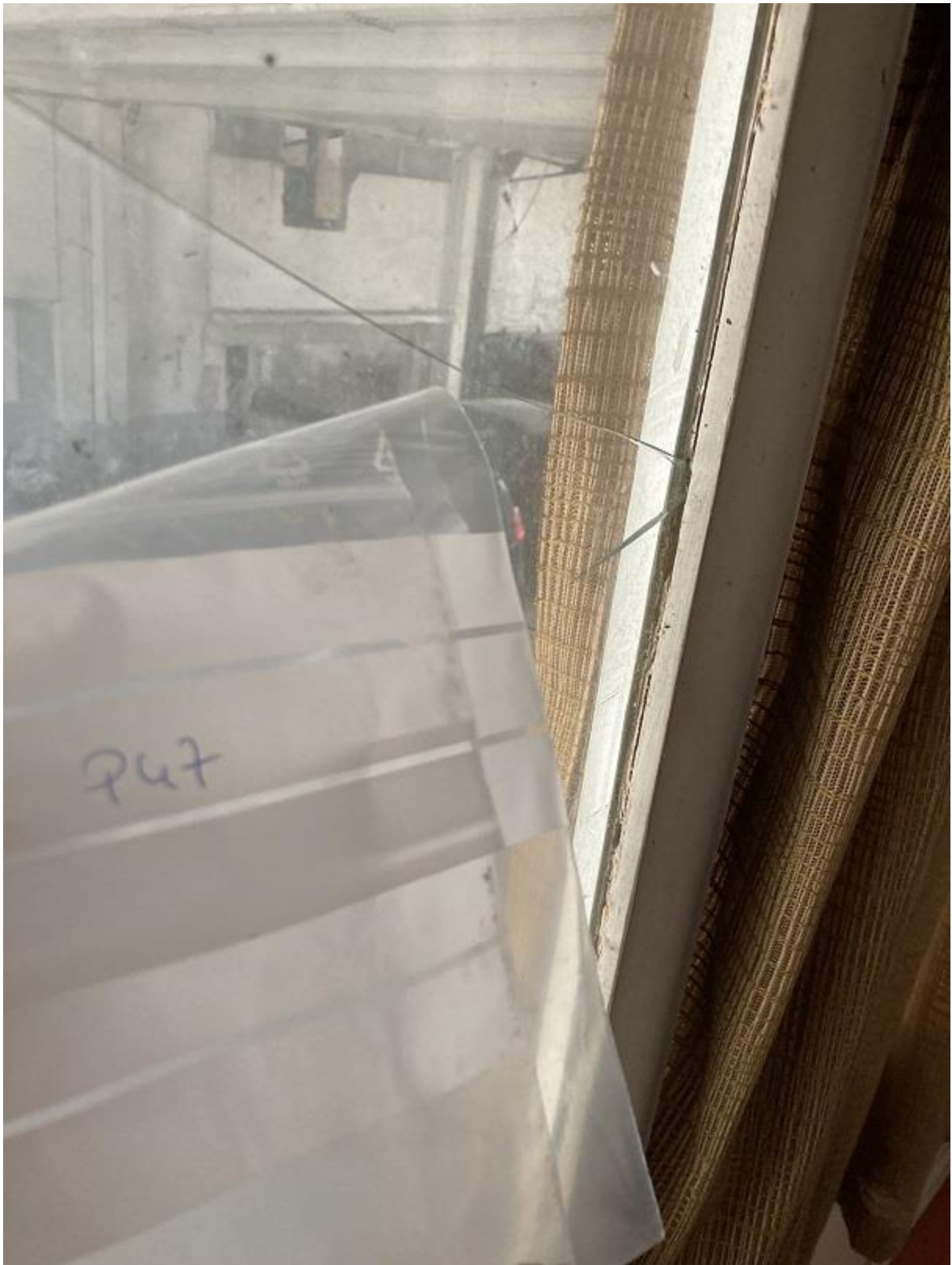
Prélèvement n°47 : Pas de fibres d'amiante détectées après analyse en laboratoire.
