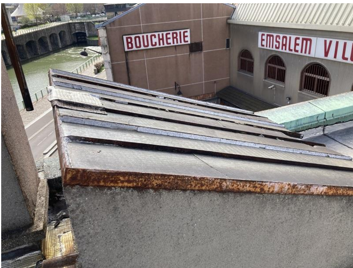
Prélèvement n°62 : Pas de fibres d'amiante détectées après analyse en laboratoire.
