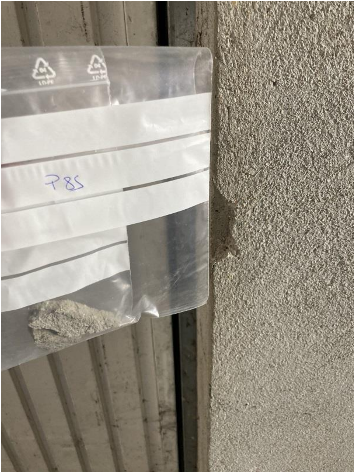
Prélèvement n°85 : Pas de fibres d'amiante détectées après analyse en laboratoire.
