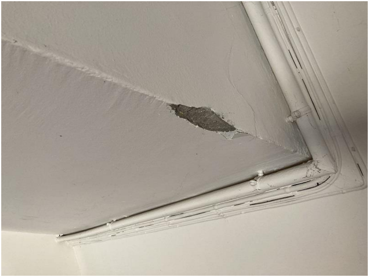
Prélèvement n°49 : Pas de fibres d'amiante détectées après analyse en laboratoire.
