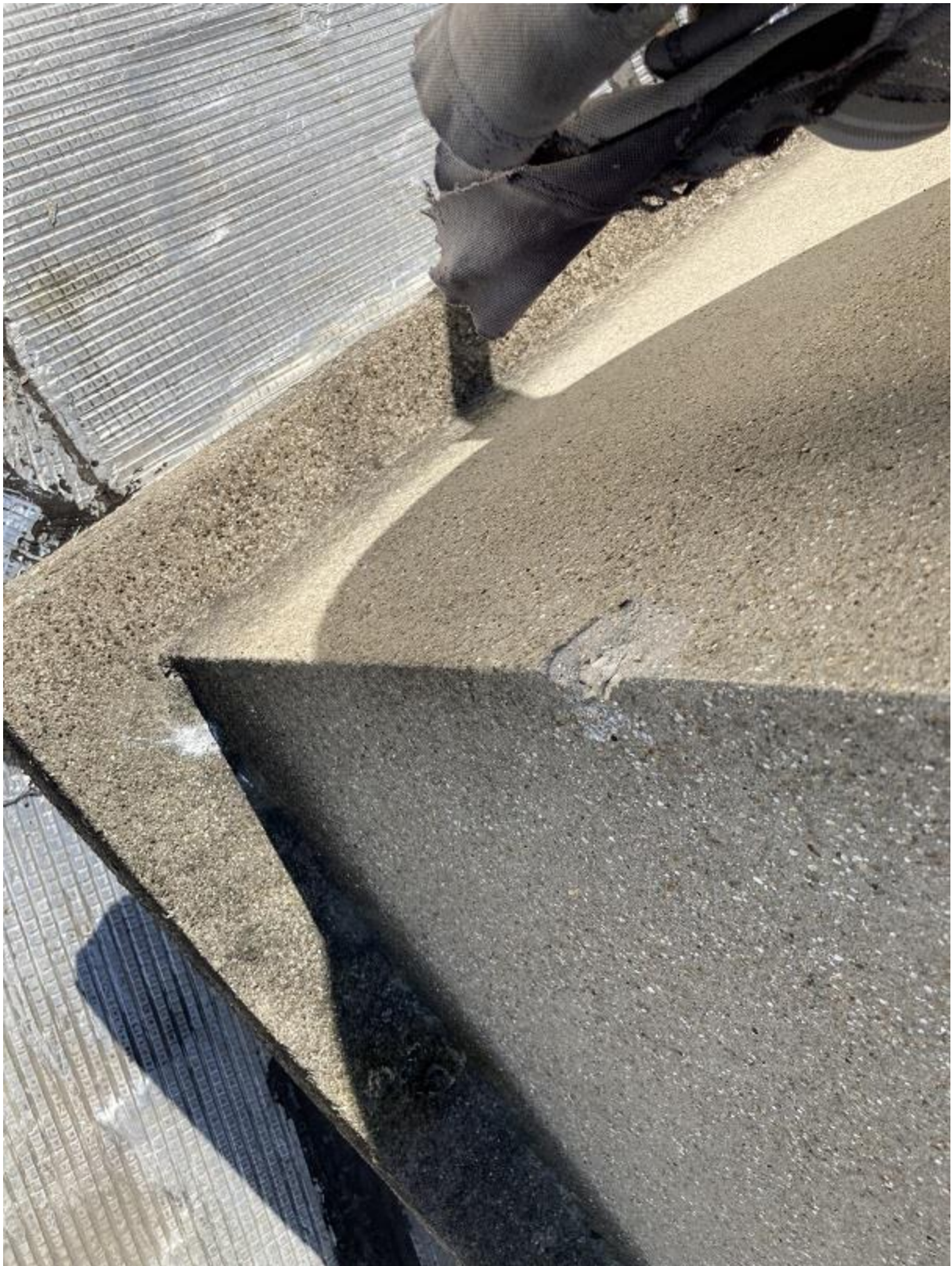
Prélèvement n°68 : Pas de fibres d'amiante détectées après analyse en laboratoire.
