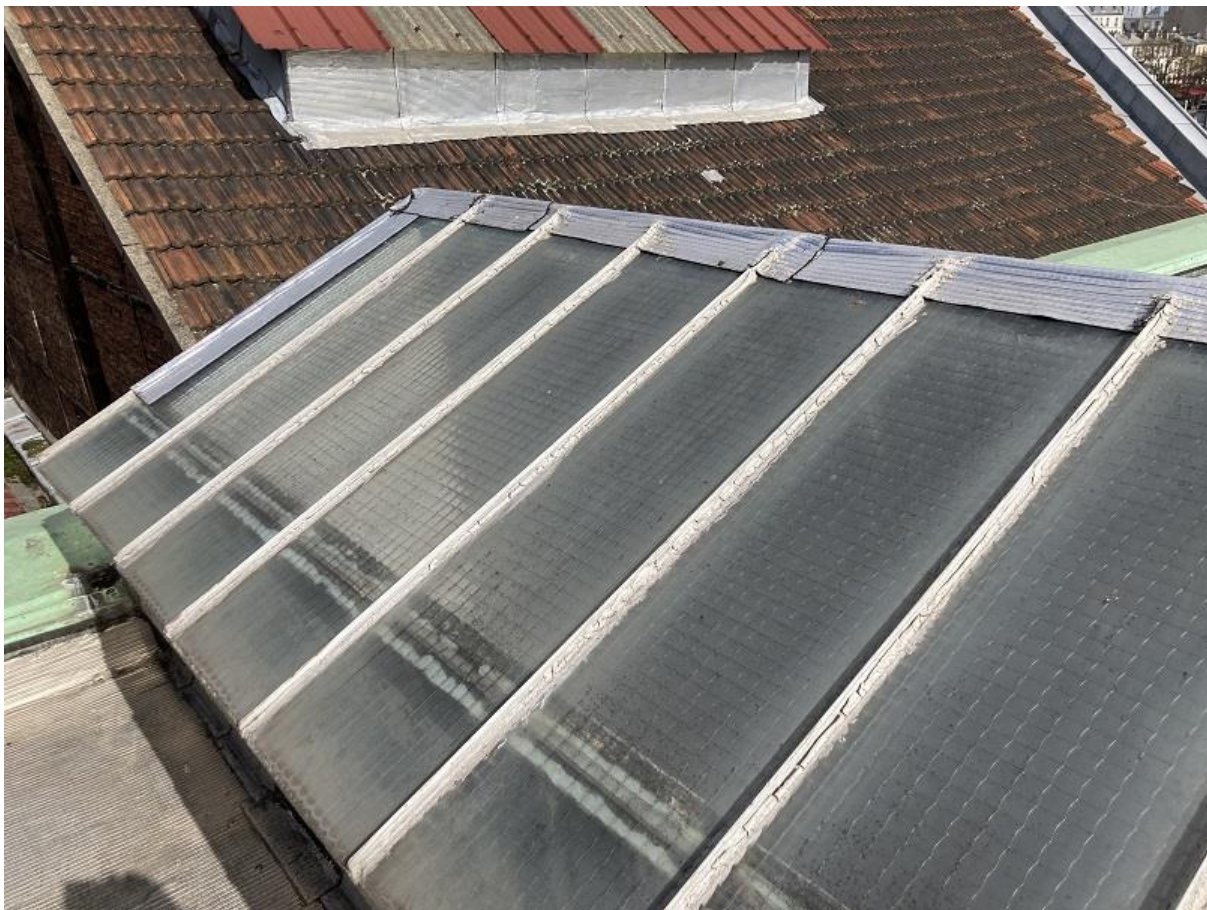
Prélèvement n°61 : Pas de fibres d'amiante détectées après analyse en laboratoire.
