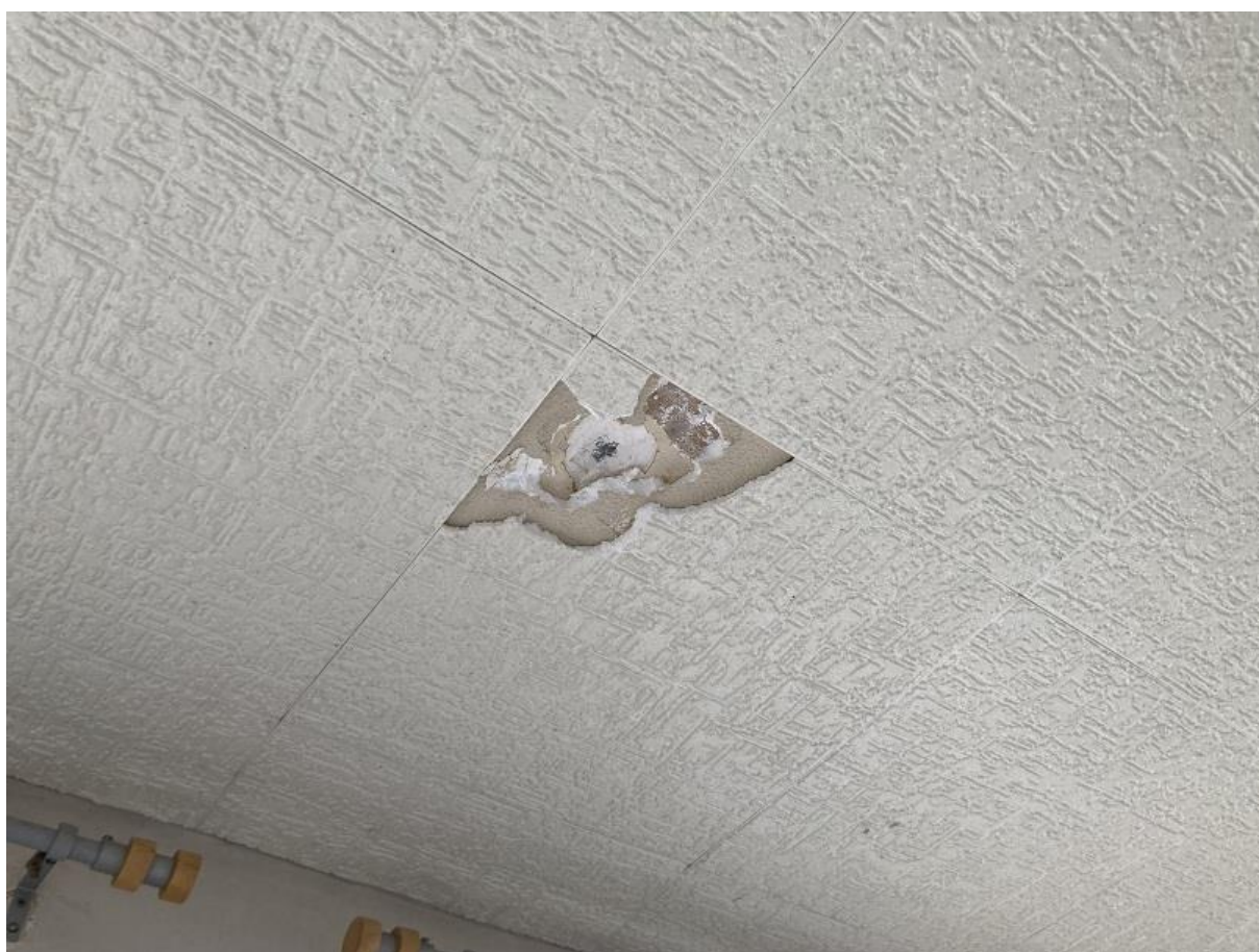
Prélèvements n°12, 13, 14 : Pas de fibres d'amiante détectées après analyse en laboratoire.
