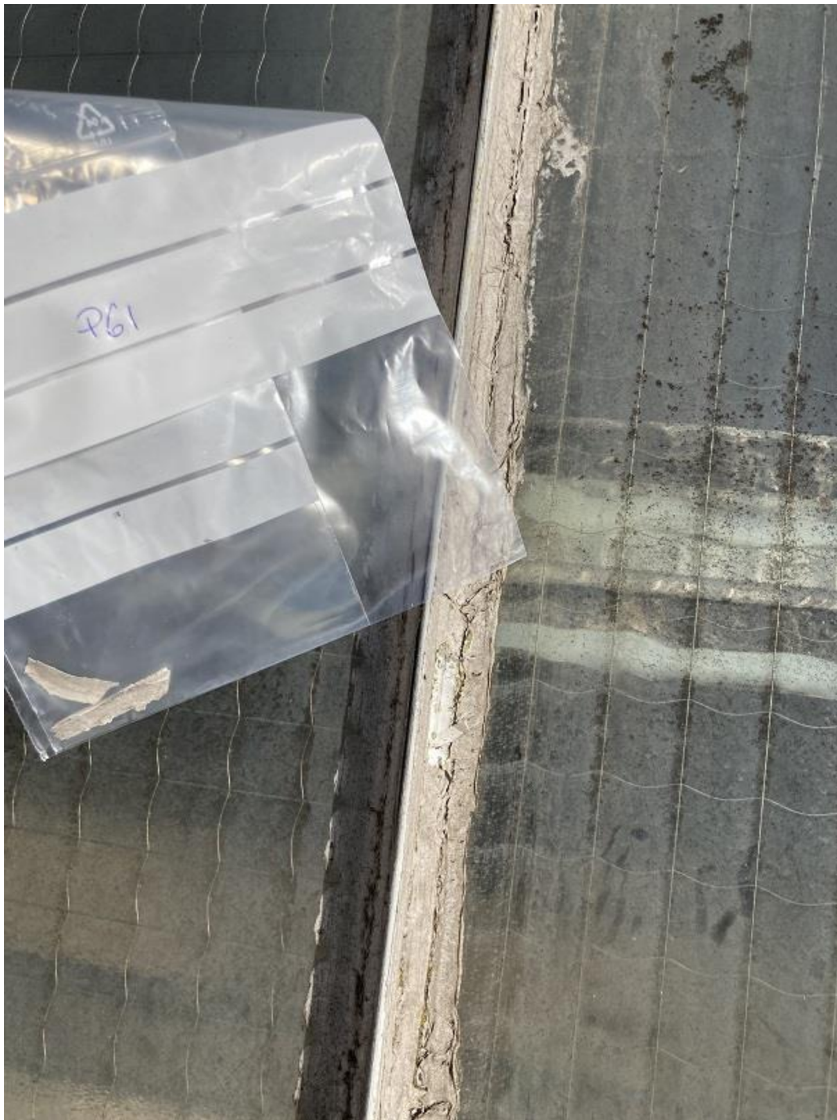
Prélèvement n°61 : Pas de fibres d'amiante détectées après analyse en laboratoire.
