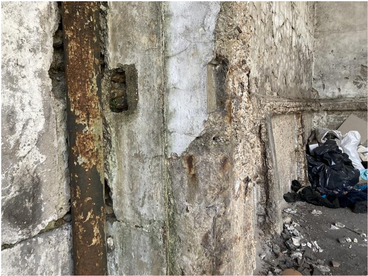
Prélèvement n°80 : Pas de fibres d'amiante détectées après analyse en laboratoire.
