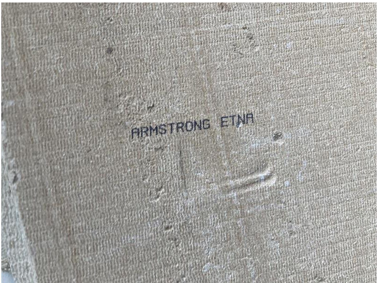
Les dalles de faux plafond de marque ARMSTRONG ne contiennent pas d'amiante.
