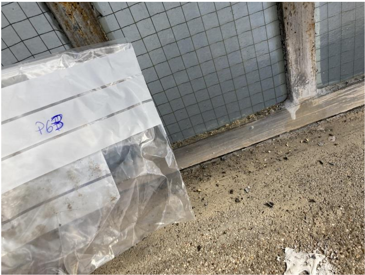
Prélèvement n°63 : Pas de fibres d'amiante détectées après analyse en laboratoire.
