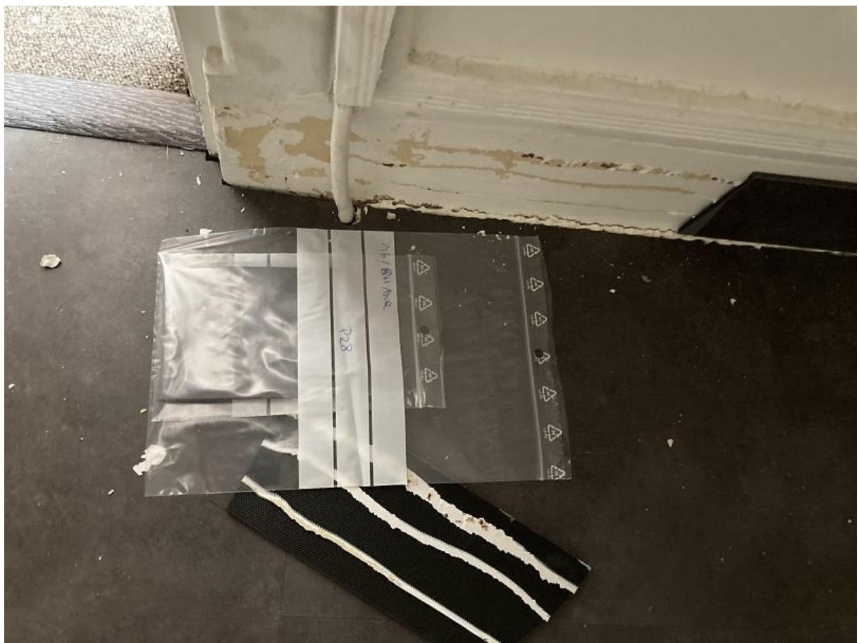
Prélèvement n°28 : Pas de fibres d'amiante détectées après analyse en laboratoire.
