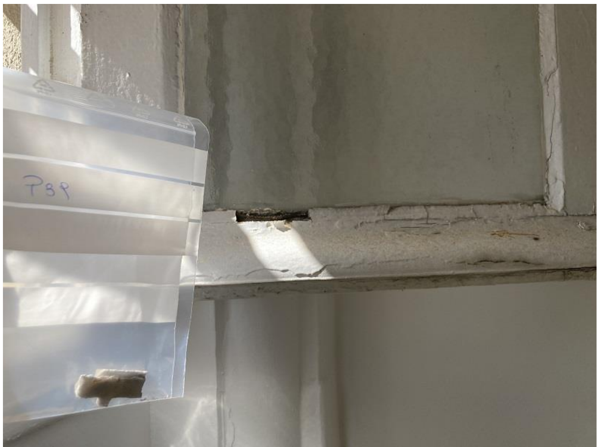
Prélèvement n°39 : Pas de fibres d'amiante détectées après analyse en laboratoire.
