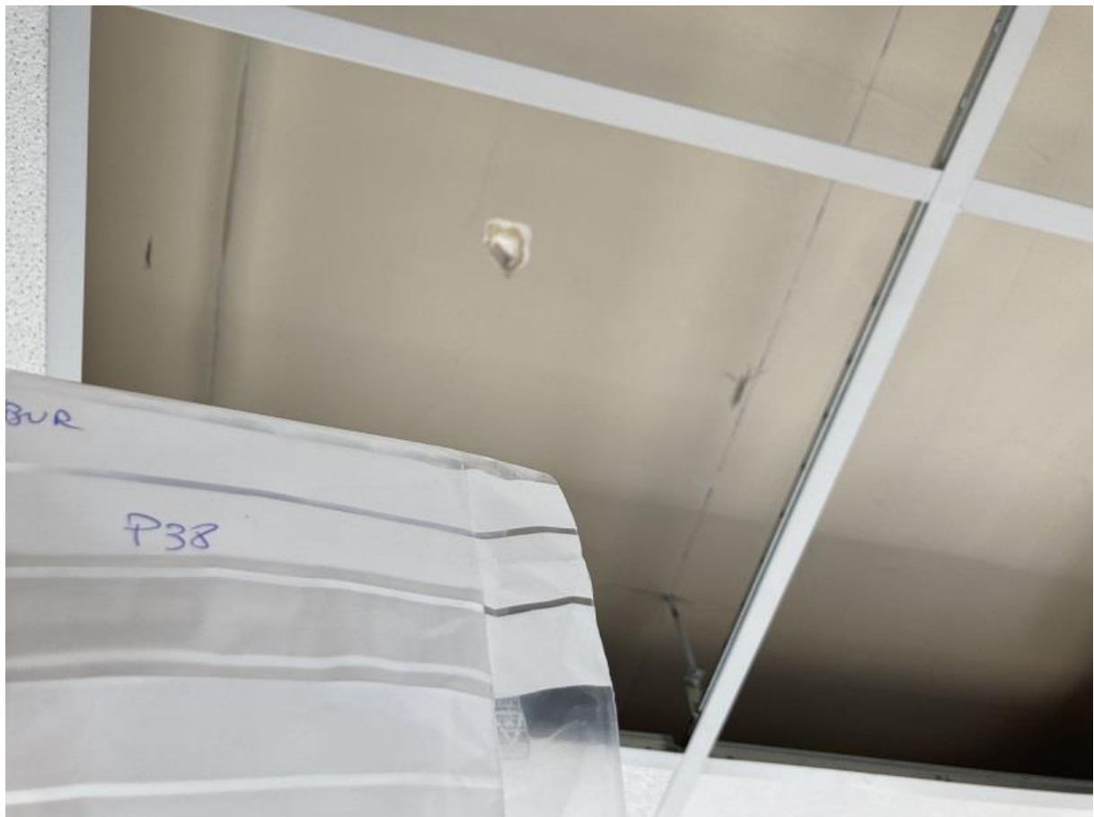
Prélèvement n°38 : Pas de fibres d'amiante détectées après analyse en laboratoire.
