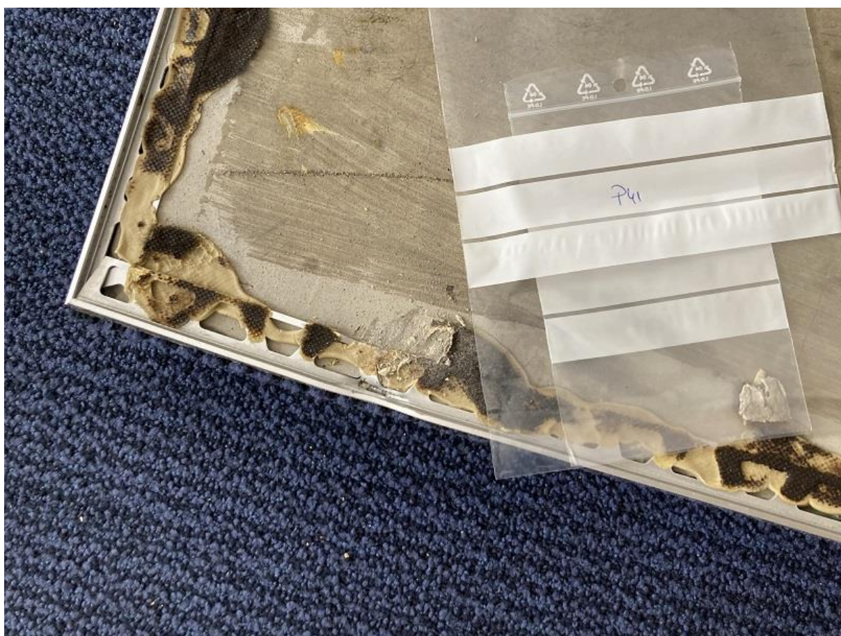
Prélèvement n°41 : Pas de fibres d'amiante détectées après analyse en laboratoire.
