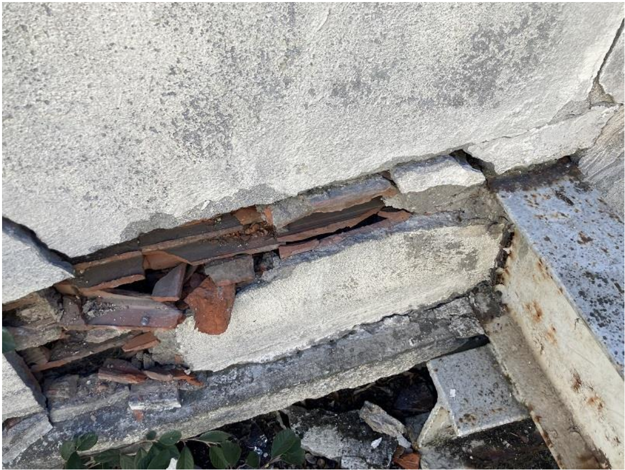
Prélèvement n°54 : Pas de fibres d'amiante détectées après analyse en laboratoire.
