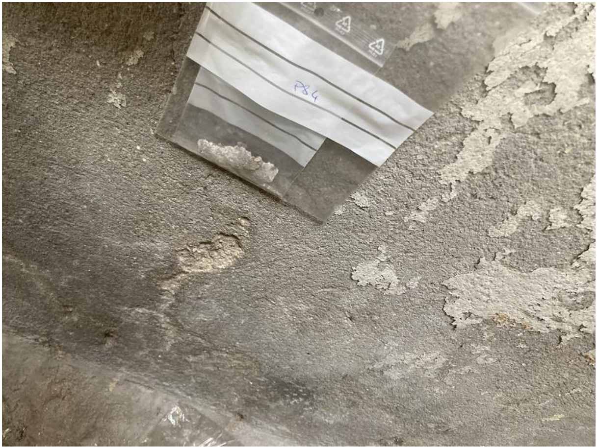
Prélèvement n°84 : Pas de fibres d'amiante détectées après analyse en laboratoire.
