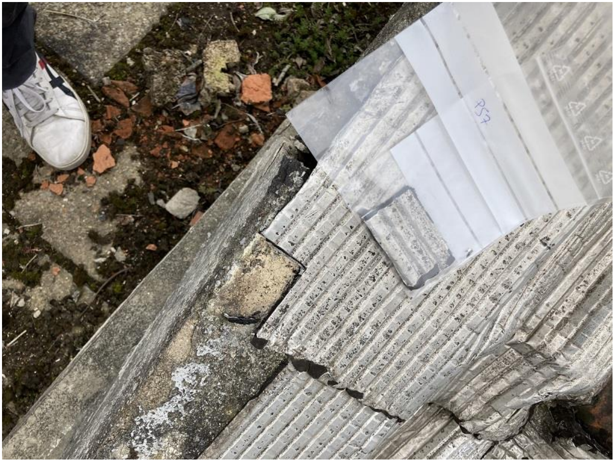
Prélèvement n°57 : Pas de fibres d'amiante détectées après analyse en laboratoire.
