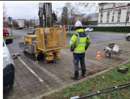
● Réalisation de sondages carottés de sols (Lot n°8)
