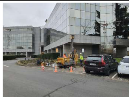
● Réalisation de sondages carottés de sols (Lot n°8)
