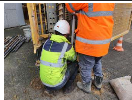
● Pose de piézair provisoire de contrôle (Lot n°1)
