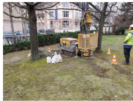
● Réalisation de sondages carottés de sols (Lot n°1)
