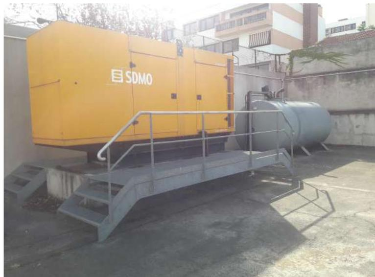
Figure 6 : Cuve de gazole de 12 000 L, localisée sur le site de BIC siège.
