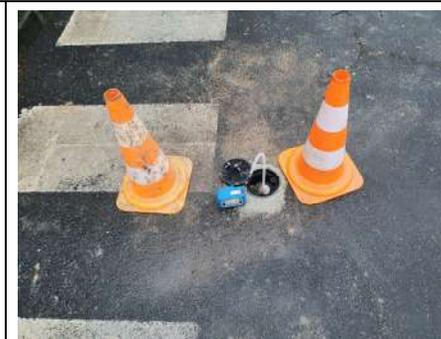
● Pose de piézair provisoire de contrôle (Lots n°3 et 4)
