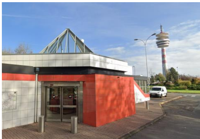
Figure 16 : Station de métro Fort de Mons
