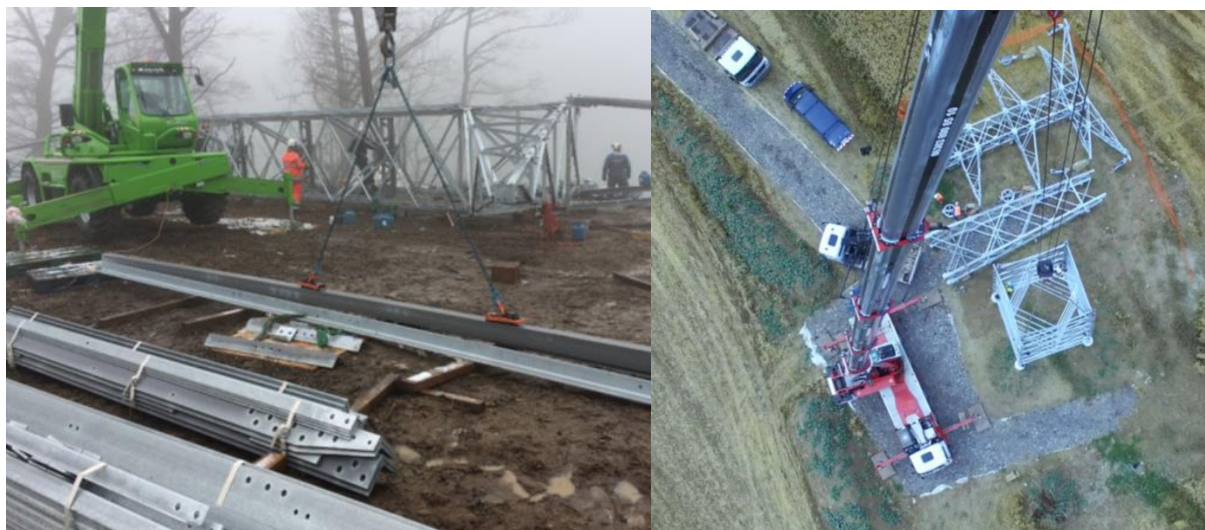
Figure 14 : Assemblage d'un pylône. Source : RTE
