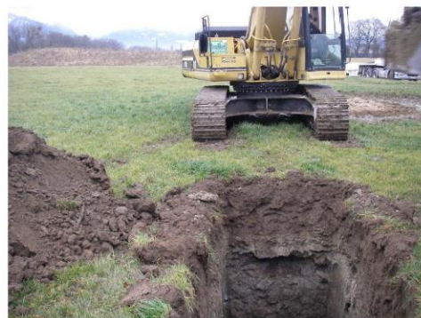
Figure 103 : Exemple de fosse creusée à la pelle mécanique
