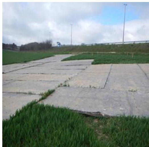
Figure 12 : Plateforme de travail. Source : RTE
