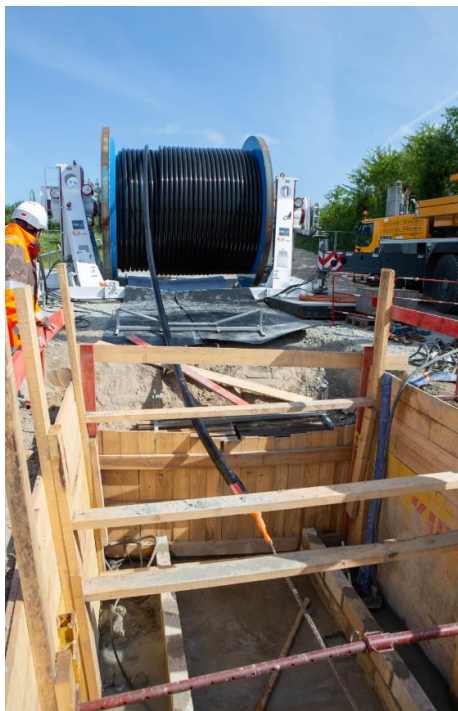
Figure 17 : Exemple d'un déroulage de câble. Source : RTE
