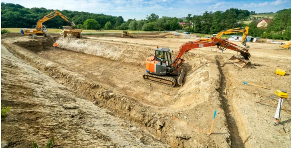
Figure 10 : Exemple de terrassement d'un poste électrique. Source : RTE
