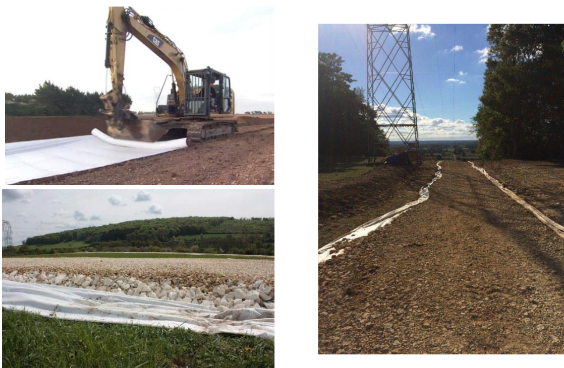
Figure 11 : Illustration de pistes provisoires. Source : RTE
