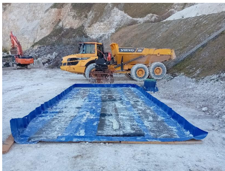
Exemple de plateforme dédiée au nettoyage des engins de chantier – collecte des hydrocarbures et résidus d'espèces exotiques envahissantes
