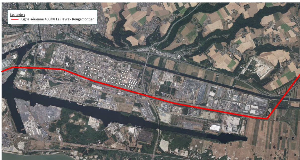
Figure 21 : Ligne aérienne 400 kV Le Havre - Rougemontier au sein de la zone industrielle du Havre
