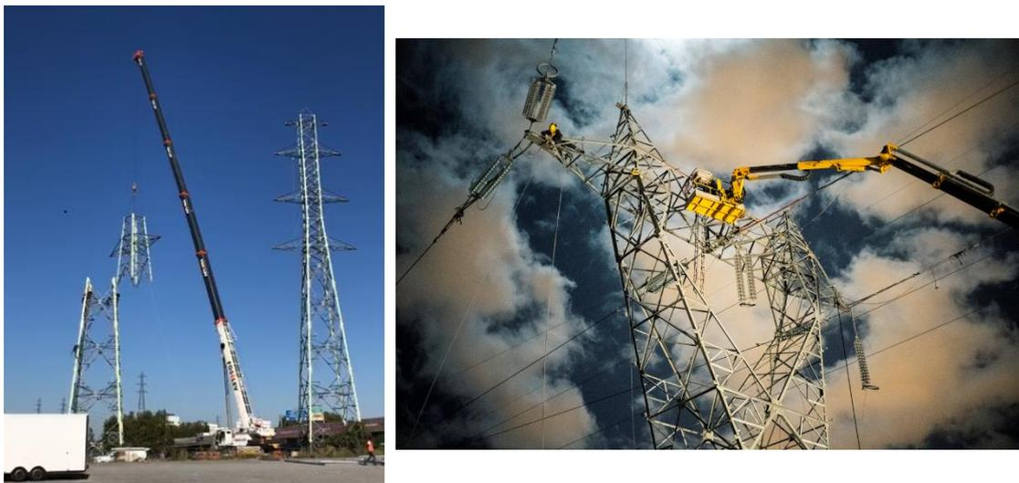
Figure 1 : Exemple de démantèlement d'une liaison aérienne
