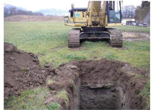
Figure 56 : Exemple de fosse creusée à la pelle mécanique
