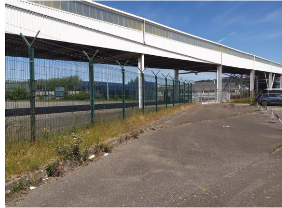
Construction avec colonie d'Hirondelles de fenêtre
