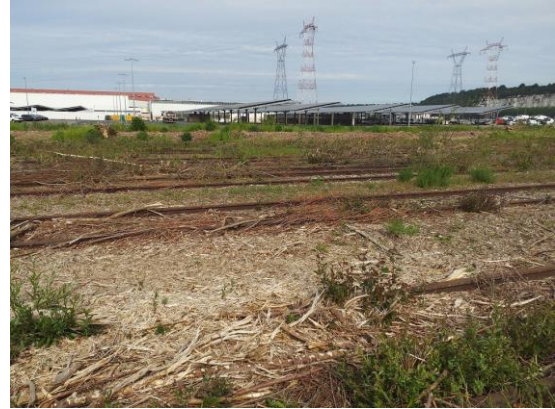
Voies ferrées récemment débroussaillées
