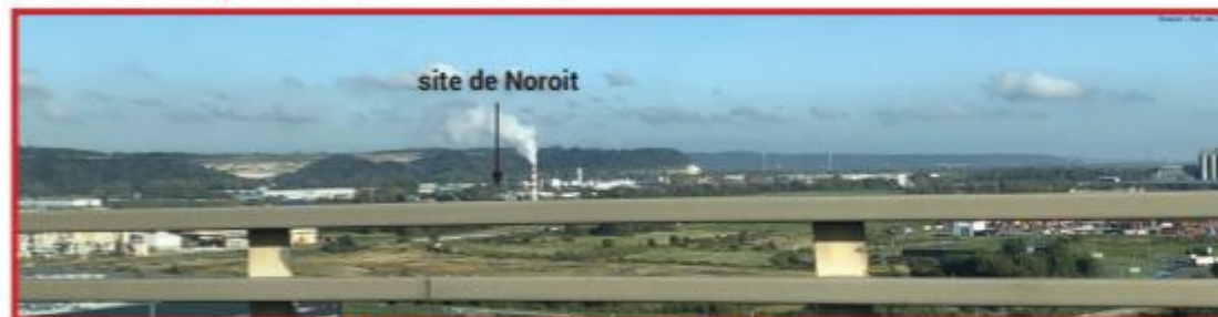
Vue depuis le viaduc du grand canal du Havre sur la zone industrielle
