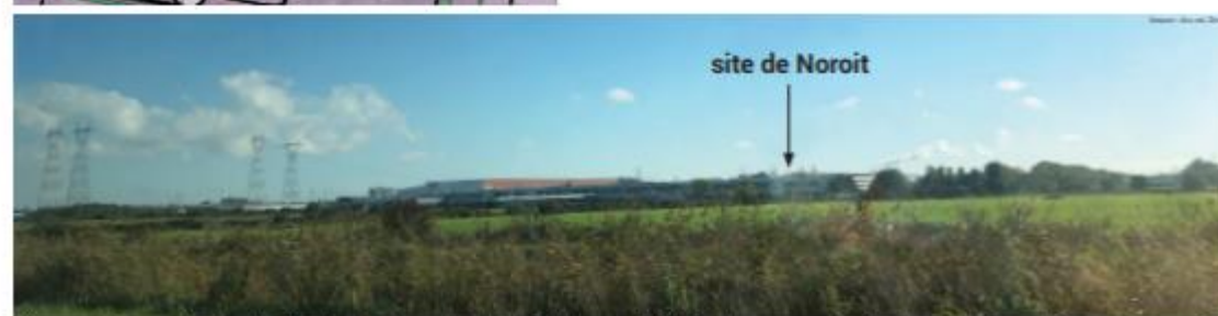
Vue sur la zone industrielle depuis la route des Falaises - D982 au hameau de Sandouville La vallée
