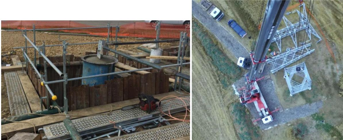
Figure 3 : Fondation et assemblage d'un pylône. Source : RTE
