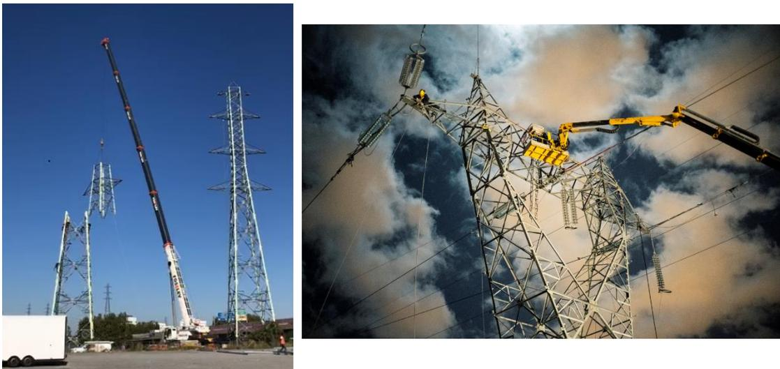
Figure 25 : Exemple de démantèlement d'une liaison aérienne
