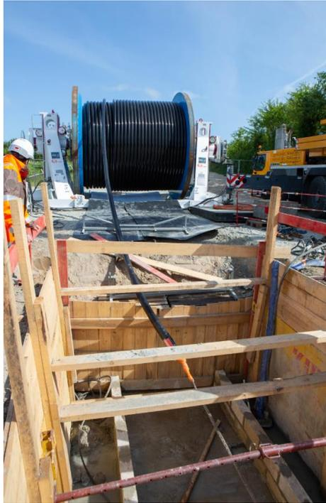
Figure 24 : Exemple d'un déroulage de câble. Source : RTE
