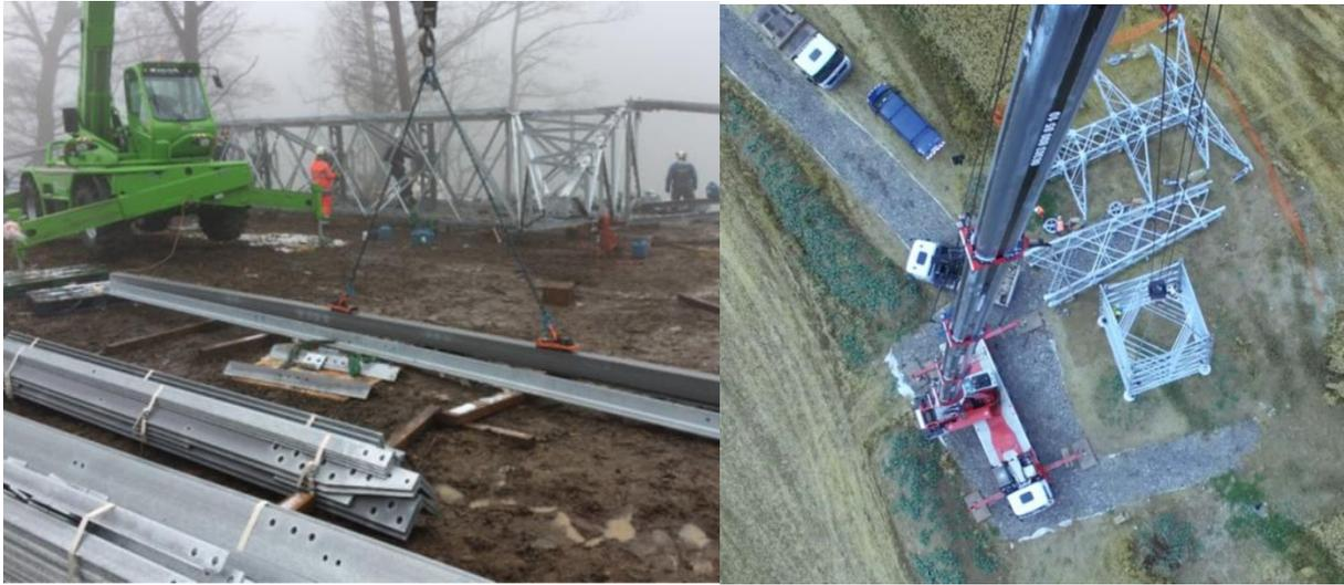
Figure 21 : Assemblage d'un pylône. Source : RTE
