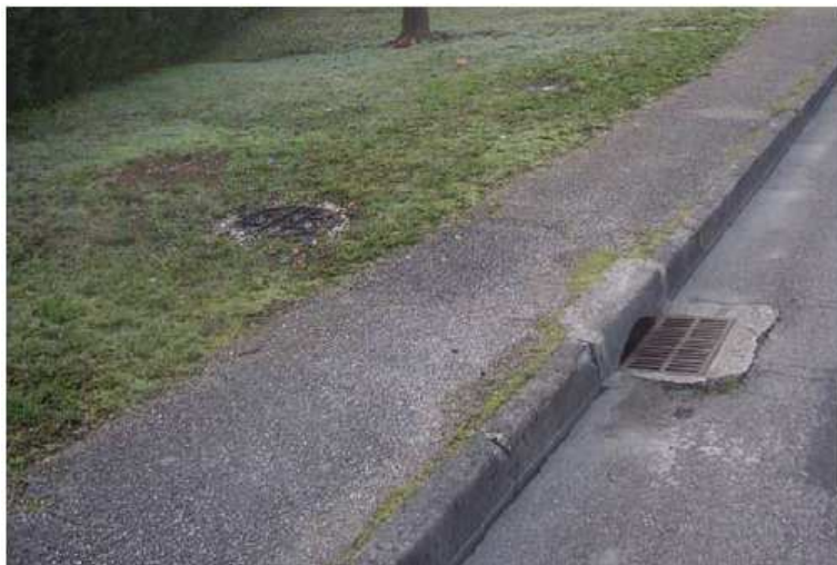
Exemple : Avaloir relié à un puits d'infiltration
