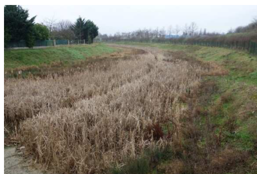
Fig. 30. Bassin de récupération des eaux du Parc départemental Saussia-Pidoux
