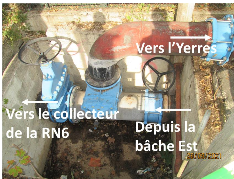
Figure 37 : Photo du système de vannage en aval de la partie Ouest (grande bête) du poste PY
