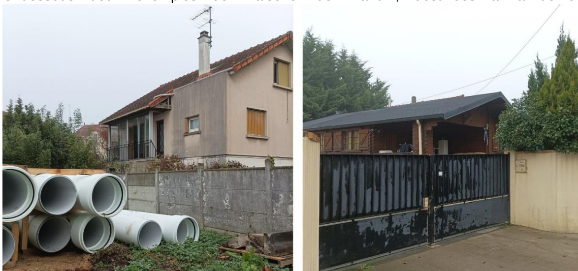
Figure 39 : Photographies des maisons sur la rue Blandin destinées à la démolition
