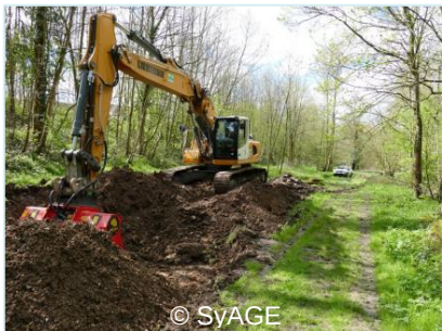
Terrassement et criblage
