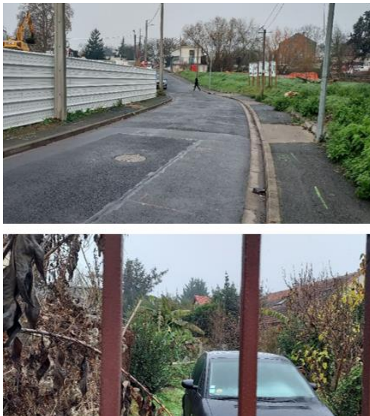
Figure 29 : Photographies issues de la visite de terrain : point bas du chemin (en haut) et chemin public approprié (en bas)
