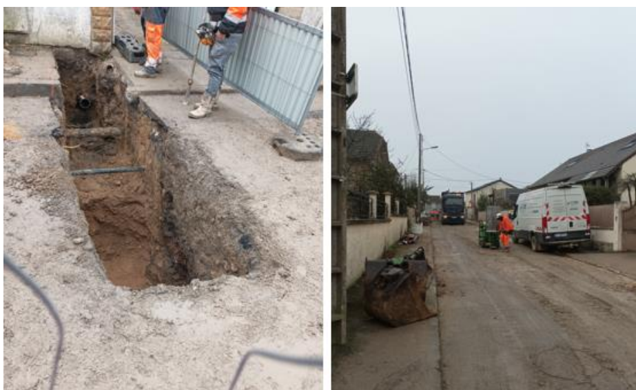
Figure 30 : Photographies des travaux d'assainissement issues de la visite
