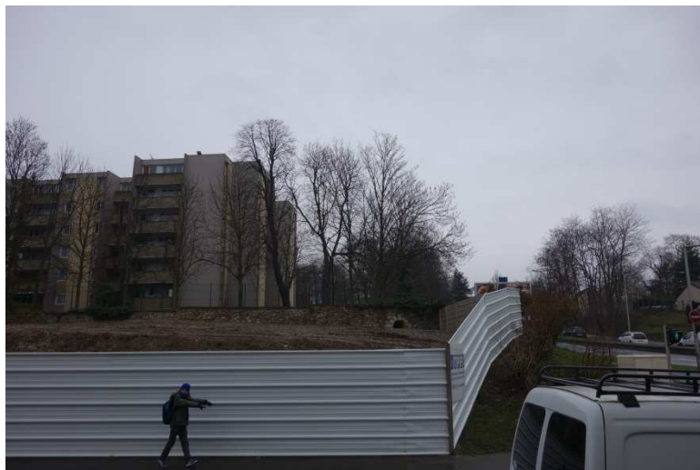
Fig. 27. Ouvrage en limite de propriété
