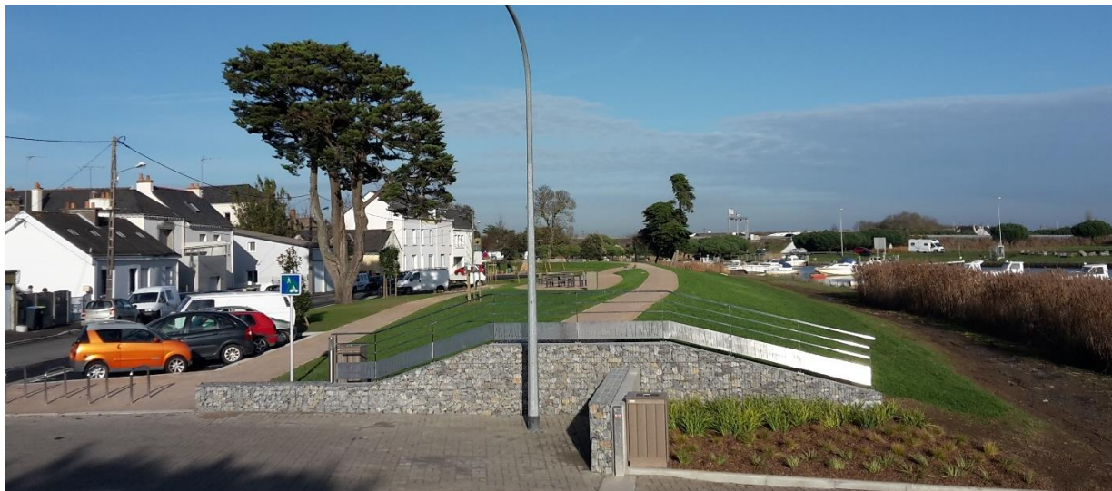
Figure 46 : Exemple de mur de fermeture d'une digue en remblai (ici béton avec habillage en cages de gabions) pour transition avec muret anti-crue et batardeau amovible – port de Méan Penhouet à Saint-Nazaire (source : Maîtrise d'œuvre SCE)
