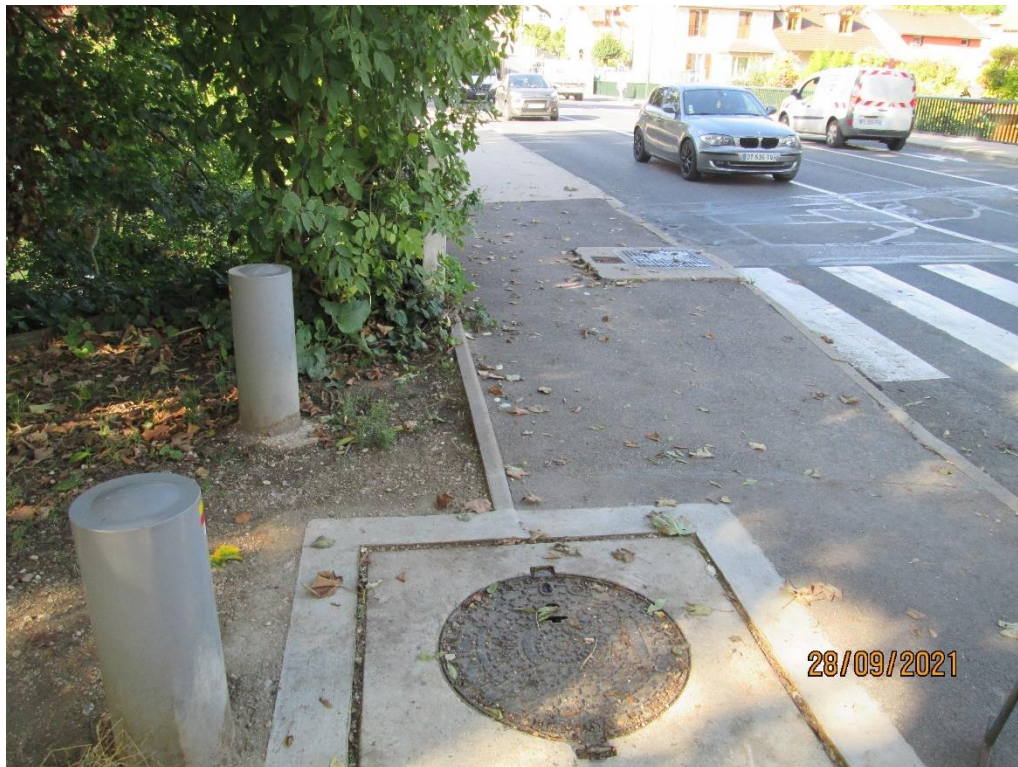
Figure 31 : Vue du regard en aval de la station P6
