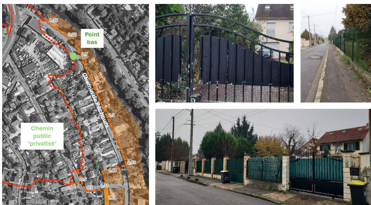
Figure 28 : Secteur Nord du système d'endiguement, vue en plan (à gauche) et photographie issue de la visite de terrain (à droite)
