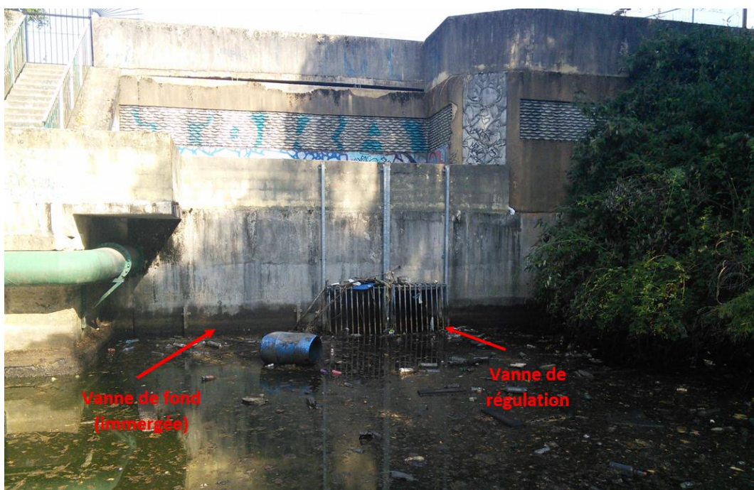
Figure n° 2 : Mur barrage de la fosse Montalbot
