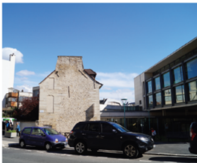
Vue de la maison et de la médiathèque depuis la rue Charles Frérot
