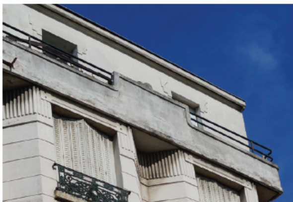
Détail du couronnement et du retrait
