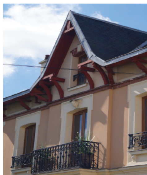
Détail des aisseliers en bois qui soutiennent le débord de toiture
