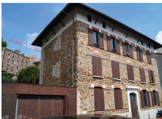
La façade principale en meulière est aujourd'hui valorisée par les nouvelles menuiseries métalliques
