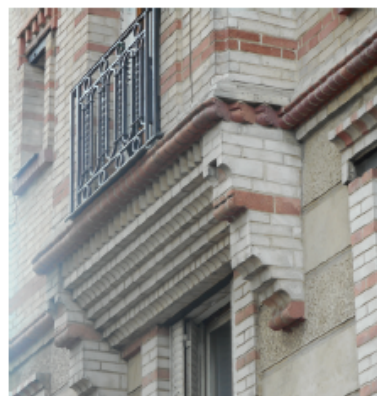
Détail de la façade : ressaut et console
