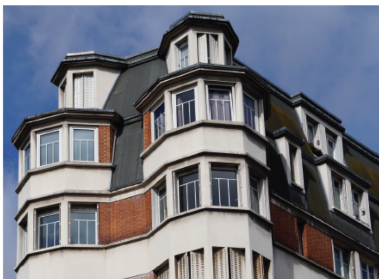
Détail du couronnement : orielles, menuiseries d'origine, alternance des bandeaux en enduit clair et en brique
