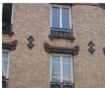
Détail de la façade
