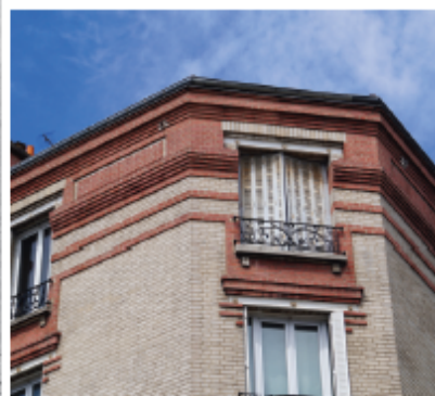
Fenêtre du dernier étage qui enjambe la corniche
