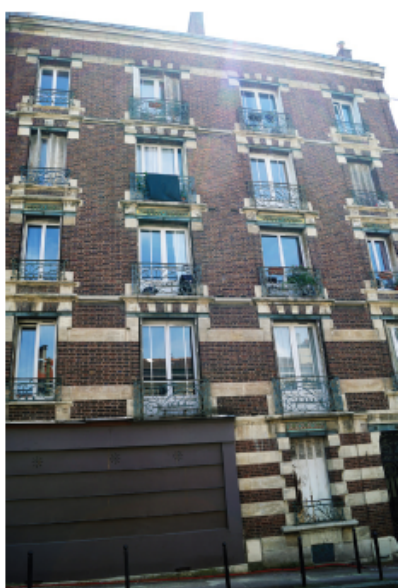
Facade sur rue du 26bis
