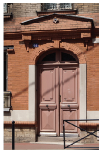
Porte d'entrée surmontée d'un tympan en brique
