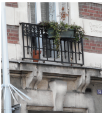
Détail du linteau au-dessus de la porte d'entrée
