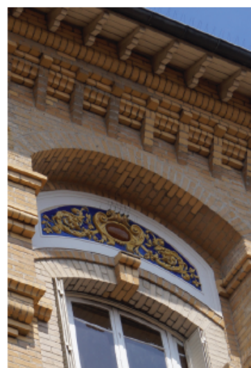
Détail de la façade : tympan
