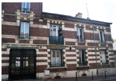
Porte d'entrée du 26 bis, façade du 26
