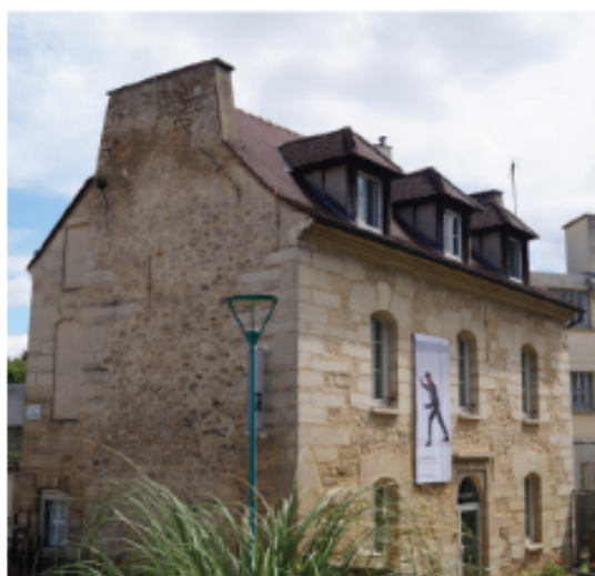
Vue du pignon et de la façade principale depuis le passage piéton (rue de la Div. du Général Leclerc)
