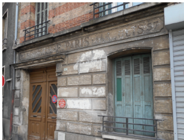
Détail de la façade
