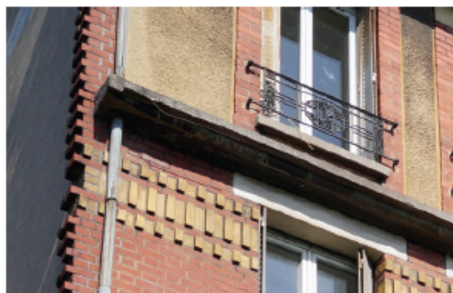
Détail des briques en attente en arrachement
