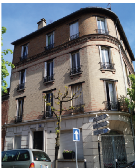
Vue de la façade au croisement entre la rue Romain Rolland et la rue Henri Kleyhoff
