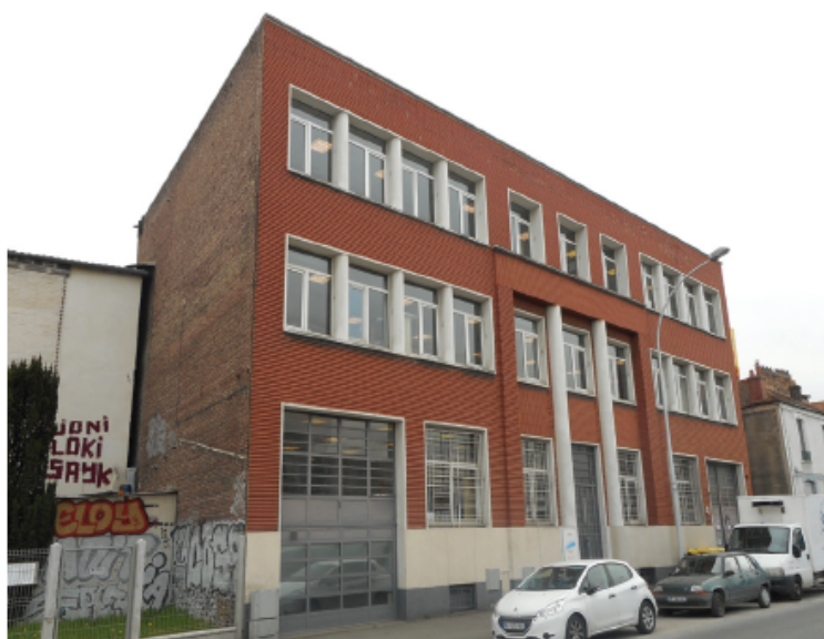
La vue montre le pignon en brique ordinaire destiné à être masqué par un bâtiment adjacent
