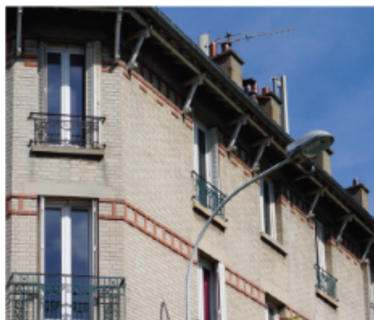
Détail de la façade et de l'avancée des toitures soutenue par les consoles en bois
