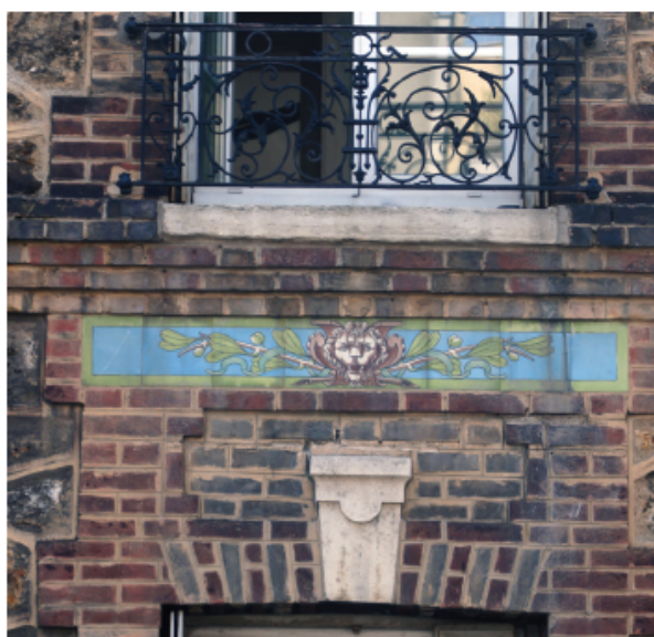
Détail de la façade : incrustation émaillée
