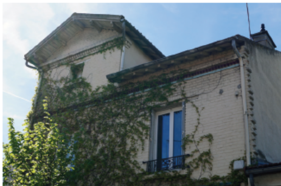
Détail de la façade
