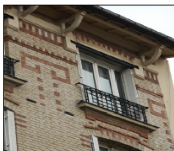
Détail de la façade
