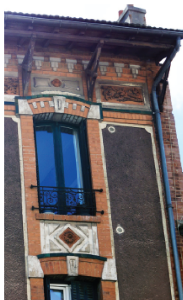
Détail de la corniche et de l'edc l'encadrement des baies
