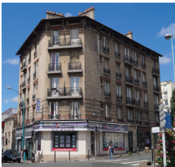
Vue du large pan coupé qui marque l'angle entre Jean-Jaurès et Raspail
