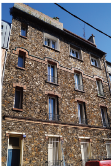
Façade sur rue : les modifications des derniers niveaux restent peu visibles
