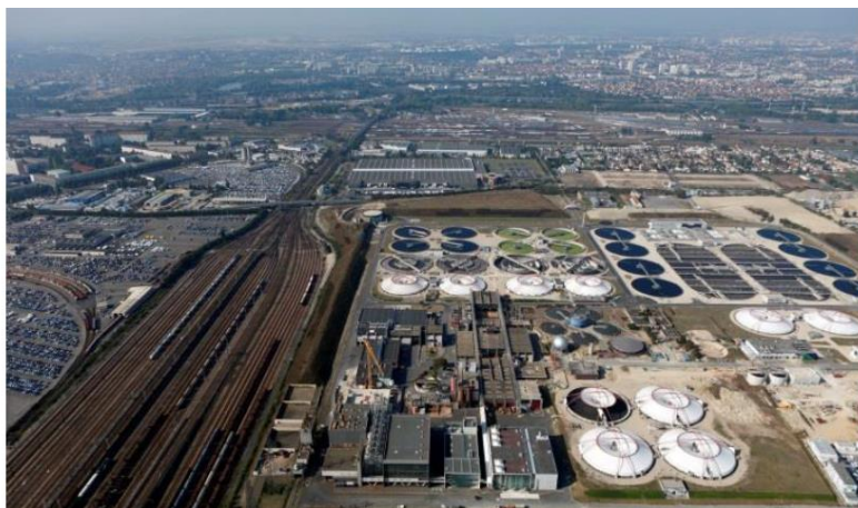
Station d'épuration de Valenton (Institut Paris Région)
