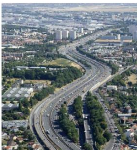
Emprise de l'autoroute A6 à L'Hay-les-Roses
