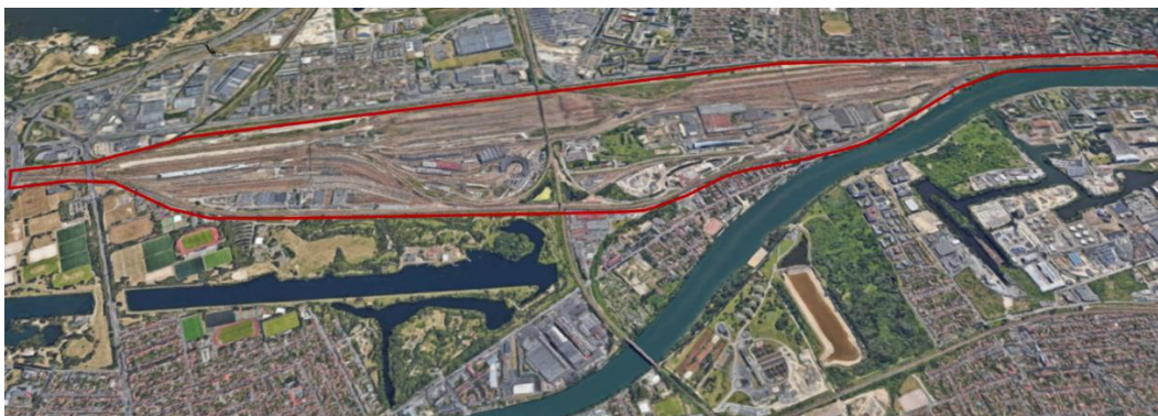
Vue 3D illustrant l’emprise ferroviaire (en rouge) à Choisy-le-Roi (Google Maps)
