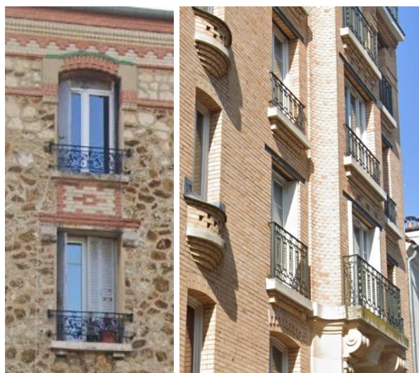
Façades, rue Jean Jaurès, Villejuif
