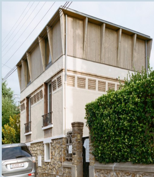
Surélévation d'une maison meulière, Benoît Rotteleur Architecte
