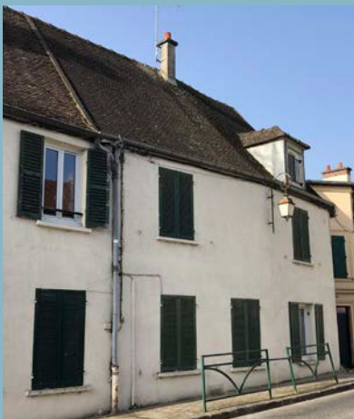
Toiture à tuiles plates au centre-ville ancien.
