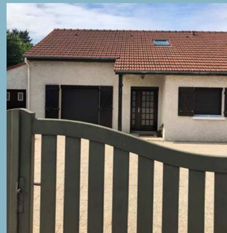
Toiture à tuiles mécaniques secteur Nord-Ouest.
