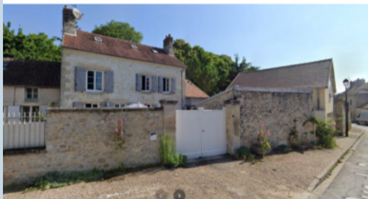
Désimpermeabilisation et végétalisation des trottoirs et des murs à Avilly-Saint-Léonard (Oise) (entretien par les habitants) source : Google Maps
