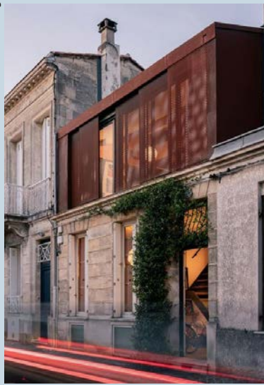
Surélévation - FELAA ARCHITECTES
