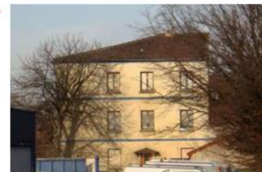
Façade Ouest, prise depuis la rue de la République
