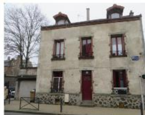
Façade Ouest rue G. Husson – Photo ASVR®
