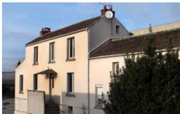
Vue façade Sud
