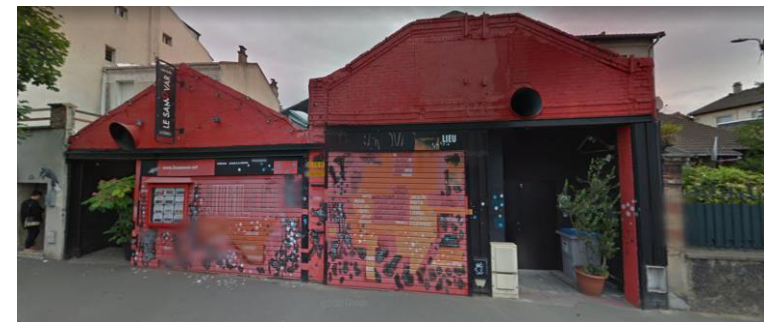
Bagnolet-Le Samovar Architecture industrielle de niveau 3
