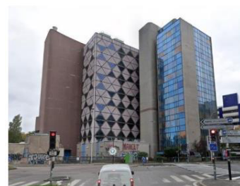
Ancien immeuble France Télécom à Bagnolet
