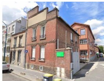
Atelier rue Méhul à Pantin
