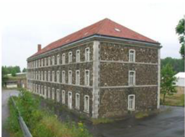
Bâtiment du fort de Romainville aux Lilas
