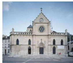
Eglise Saint-Pierre-Saint-Paul à Montreuil
