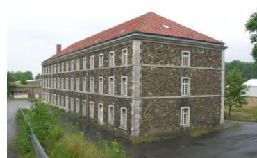
Bâtiment du fort de Romainville aux Lilas
