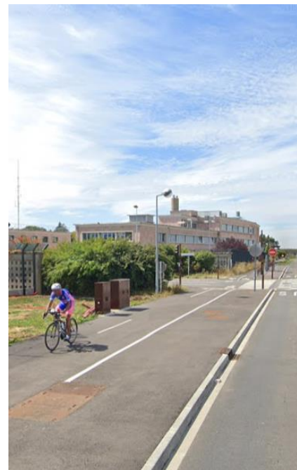
Piste cyclable à double sens séparée de la chaussée
