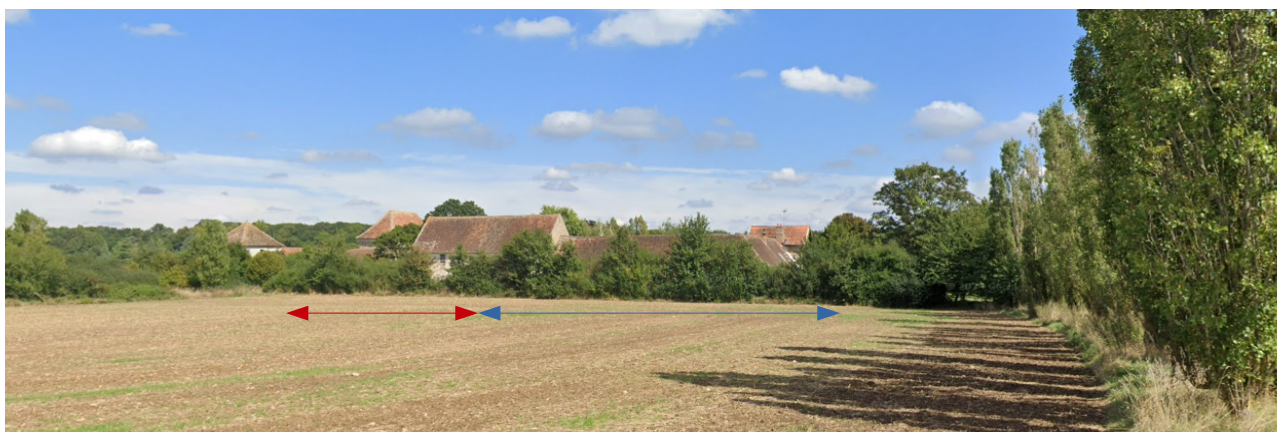
Vue générale de la ferme des Arpentis depuis le flanc Ouest. En rouge, les bâtiments protégés monuments historiques et en bleu les bâtiments non protégés - Cliché Google street view
