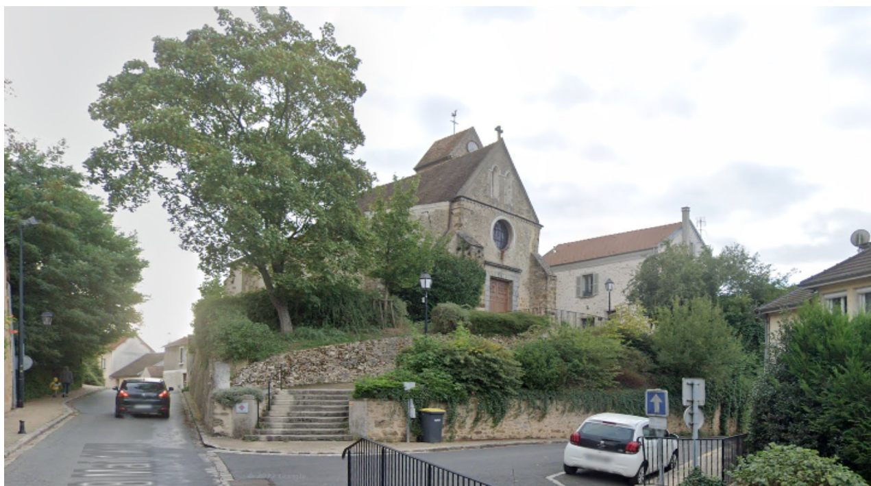
Vue générale du mur de soutènement qui entoure l'église - Cliché Google street view
