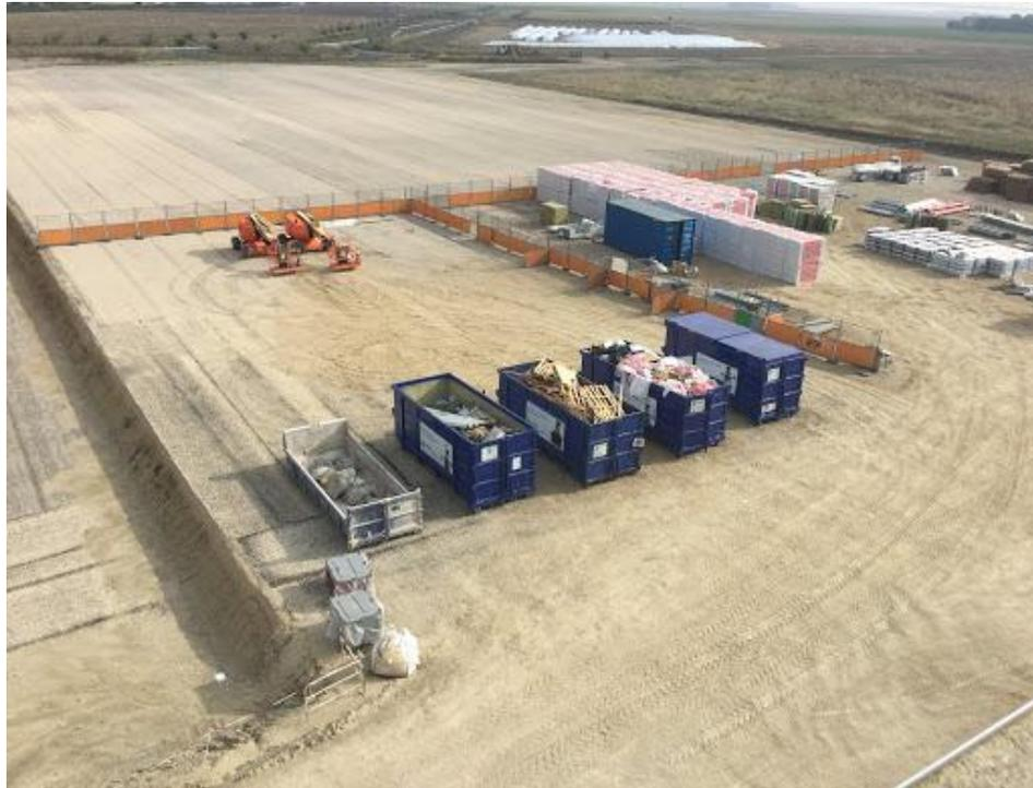
*Figure 101 : Bennes de tri des déchets sur un chantier*
