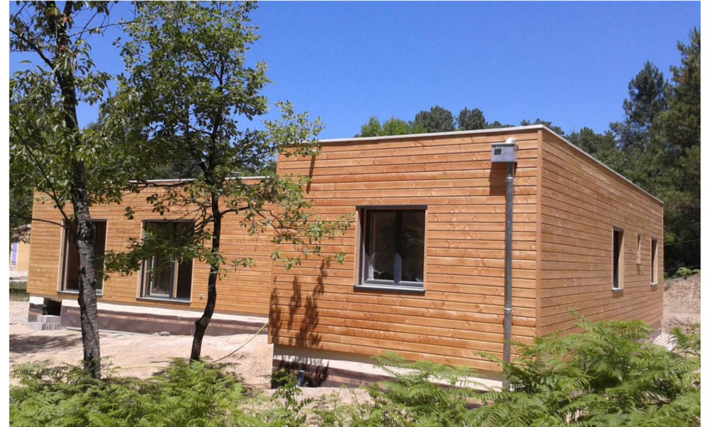
Exemple de bardage bois pouvant être utilisé dans le cadre de l'habillage du poste de livraison
