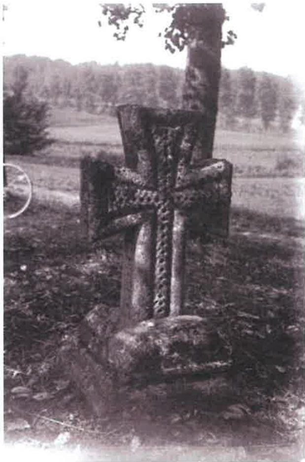
Photographie ancienne, base Mérimée
