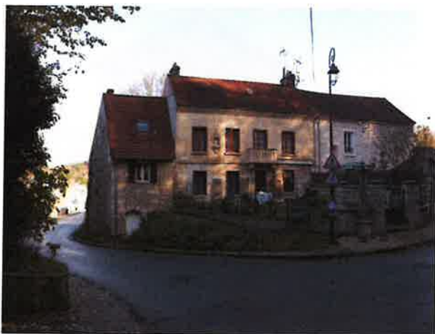
13- Angles de la rue du Chenival et rue de Pontoise
