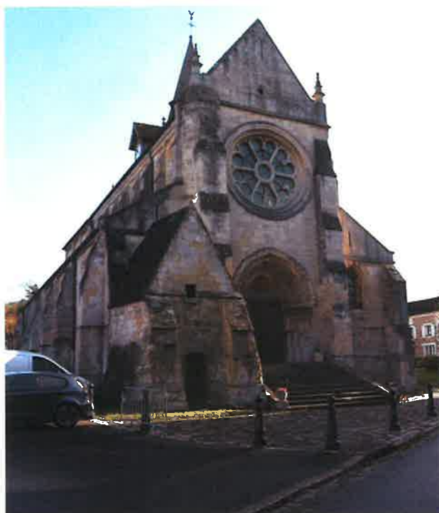
2- Façade occidentale, rue Pierre Pilon
