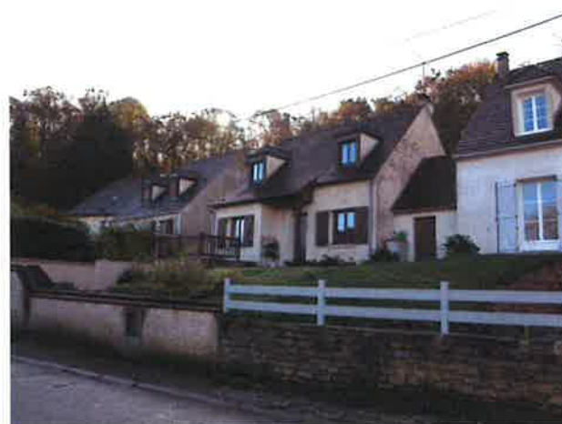
12- Rue de la l'Oeuf
