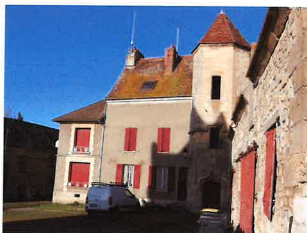
2- Tourelle d'escalier dont la porte possède un linteau à accolade
