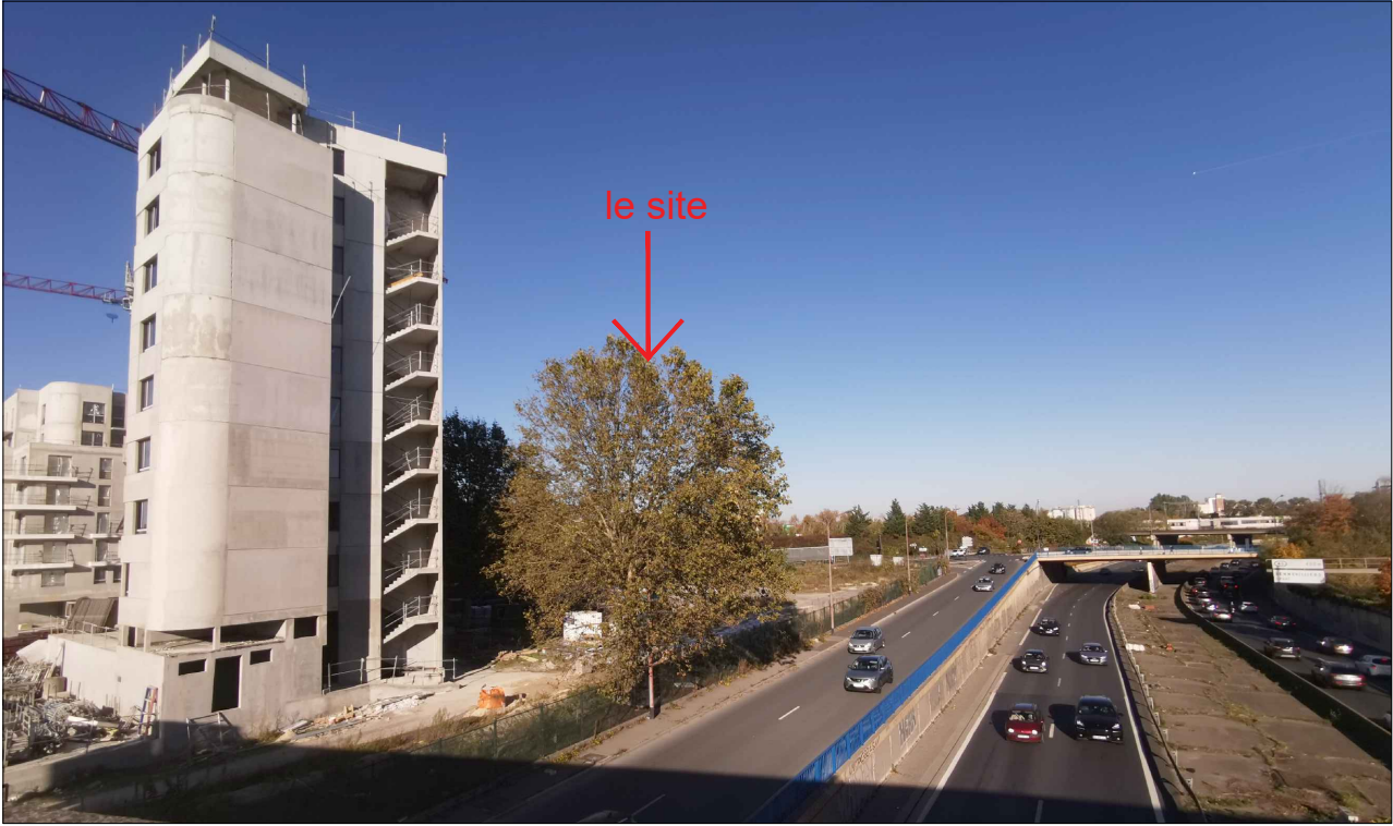
VUE 4 PONT SUR AUTOROUTE A86
