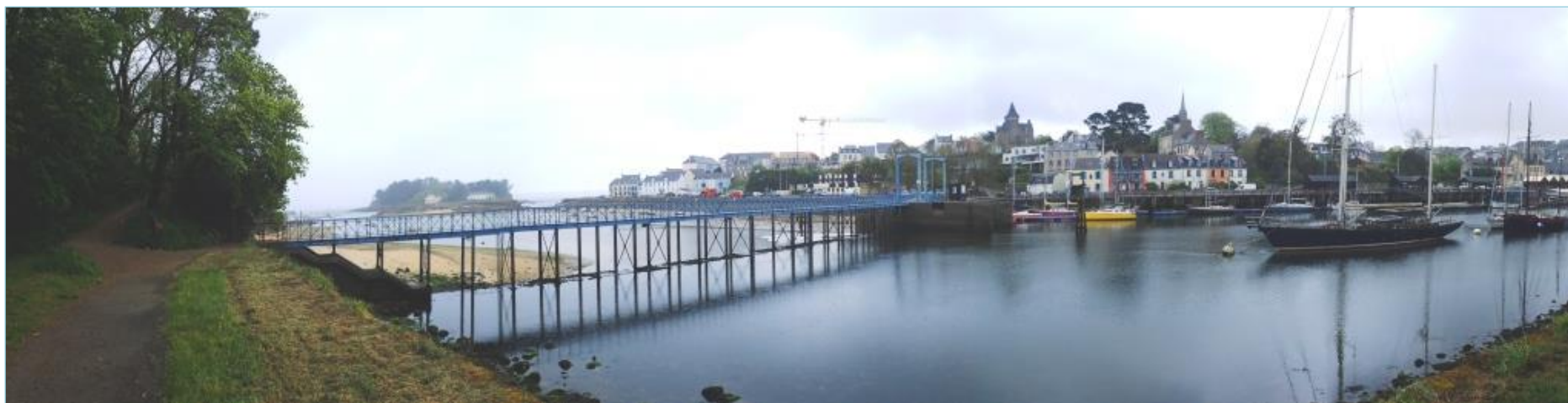
Figure 3 – Vue du chemin du Treiz sur la rive ouest avec la grève du Guet, l'Île Tristan au fond, la passerelle Pierre Marin, l'estuaire de Pouldavid et le Port Rhu.
