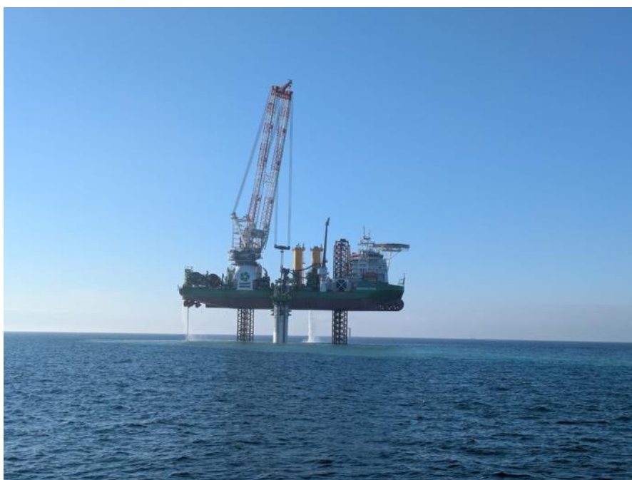
Figure 4 : exemple de forage sur le champ éolien de Noirmoutier - île d'Yeu
