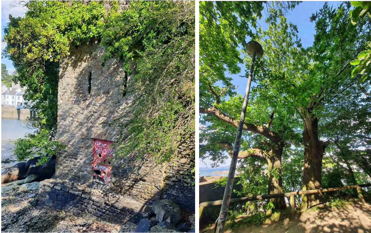
Tourelle et vieil arbre sénescents potentiellement favorables à l'accueil de chauves-souris
