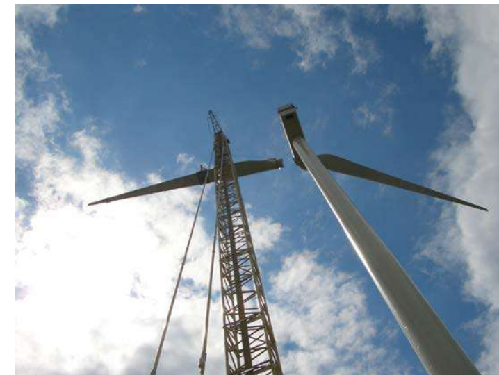
Photographie 20 : Assemblage d'une pale
