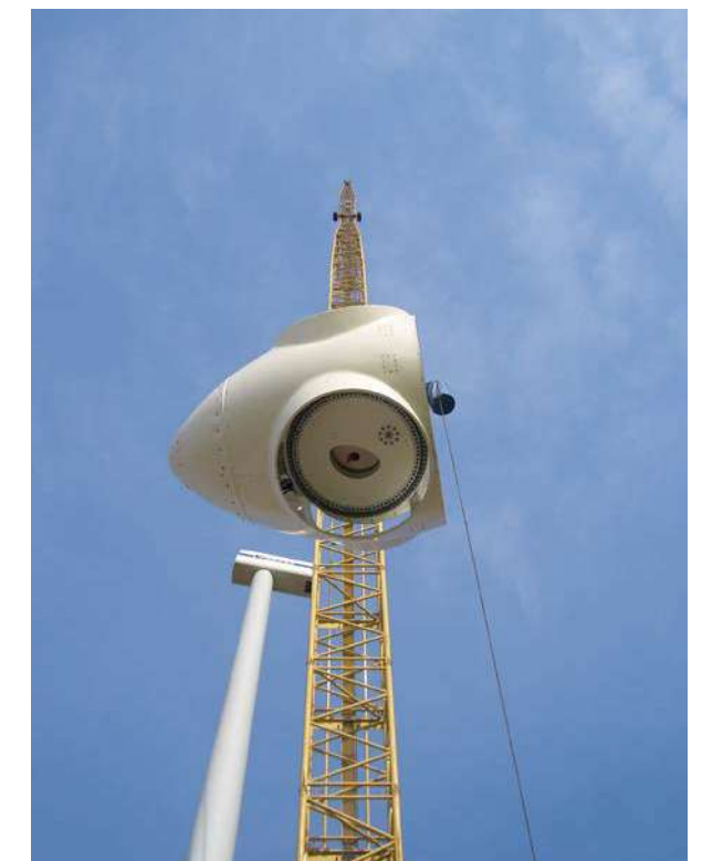
Photographie 22 : Levage du moyeu en fonte
