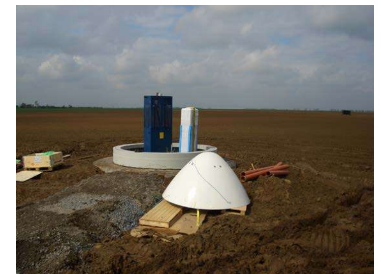
Photographie 13 : Embase de l'éolienne équipée d'une armoire électrique, fondation enterrée
