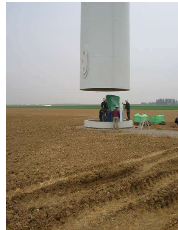
Photographie 19 : Ajustement de la première section de mât sur l'embase
