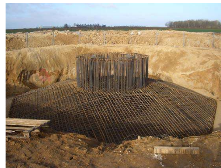
Photographie 10 : Armature d'acier de la fondation
