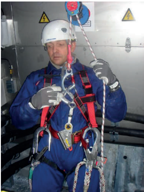
Accrocher l'équipement de descente d'urgence aux anneaux en D situés à l'avant du harnais et tirer sur la corde pour la tendre.
