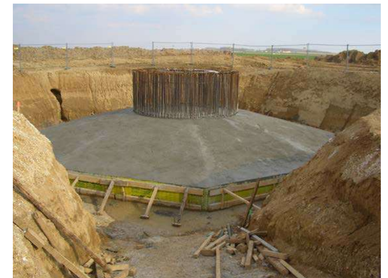
Photographie 11 : Coulage du béton sur l'armature
