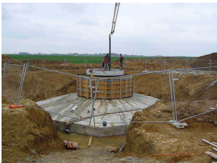
Photographie 16 : Coulage du béton solidarisant la virole au massif
