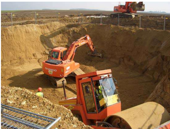
Photographie 15 : Excavation et terrassement pour l'installation des fondations
