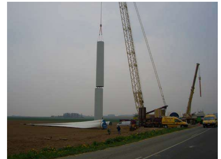
Photographie 21 : Assemblage des deux premières sections du mât
