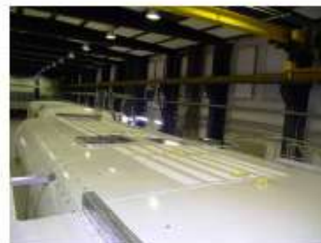
Illustration 22-8 : Points d'ancrage situés sur le toit de la nacelle.
