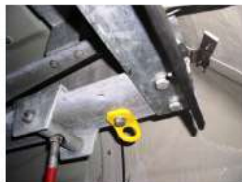
Illustration 22-7 : Point d'ancrage situé au niveau du rail du treuil.
