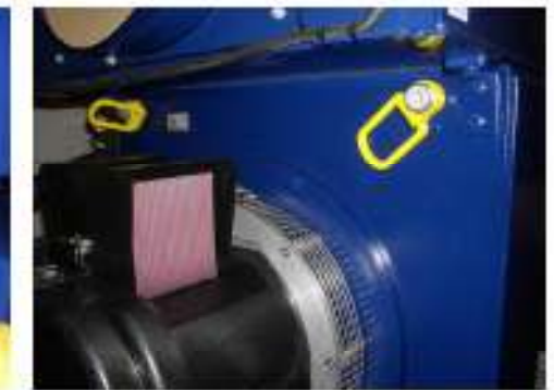
Illustration 22-2 : Points d'ancrage situés à l'arrière du générateur.
