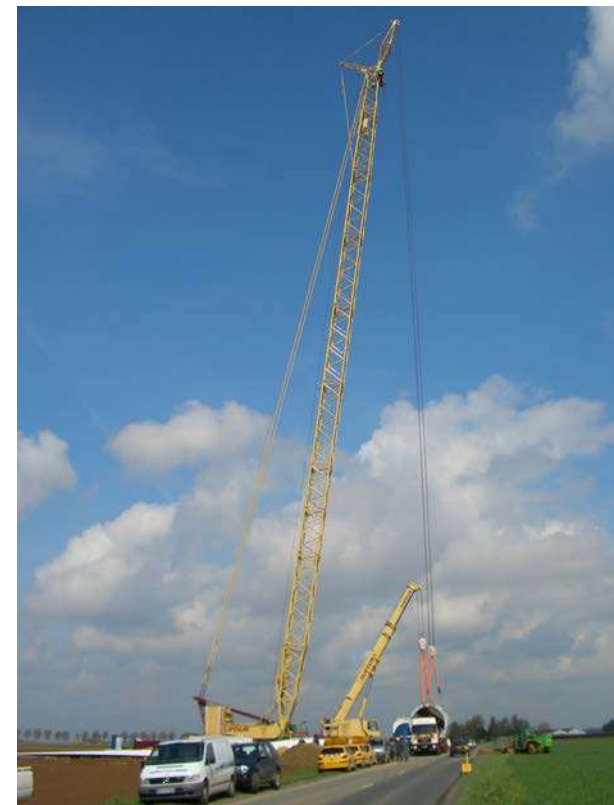
Photographie 18 : Levage d'une section de mât par la grue principale assistée de la grue auxiliaire
