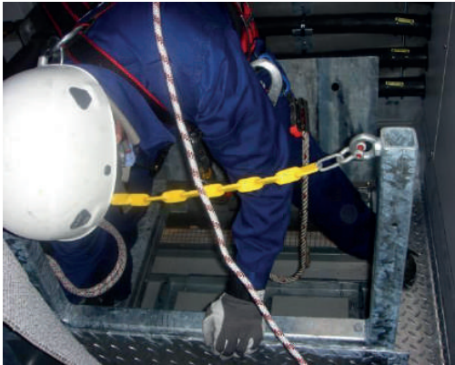
Ouvrir les panneaux de sortie de secours dans la nacelle.
