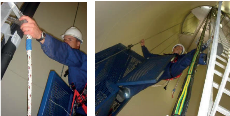
Fixer le mousqueton de la longe de maintien autour des montants de l'échelle. Attraper l'échelle d'une main et placer l'autre pied sur l'échelle.
