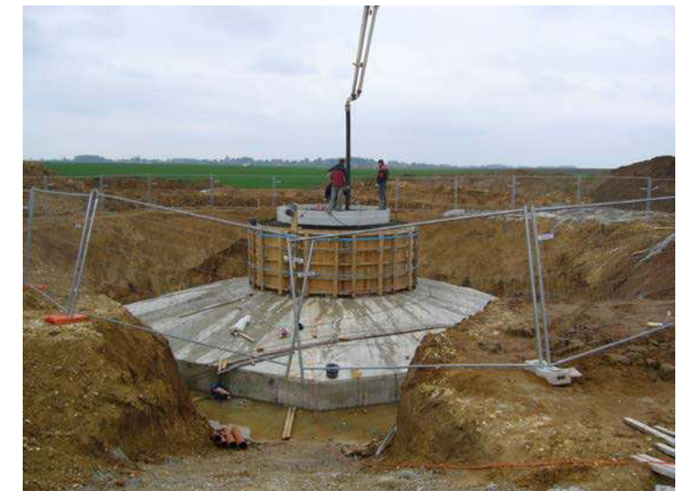
Photographie 12 : Béton solidarisant la caisse d'ancrage au massif
