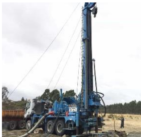
machine de forage
