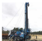
machine de forage
