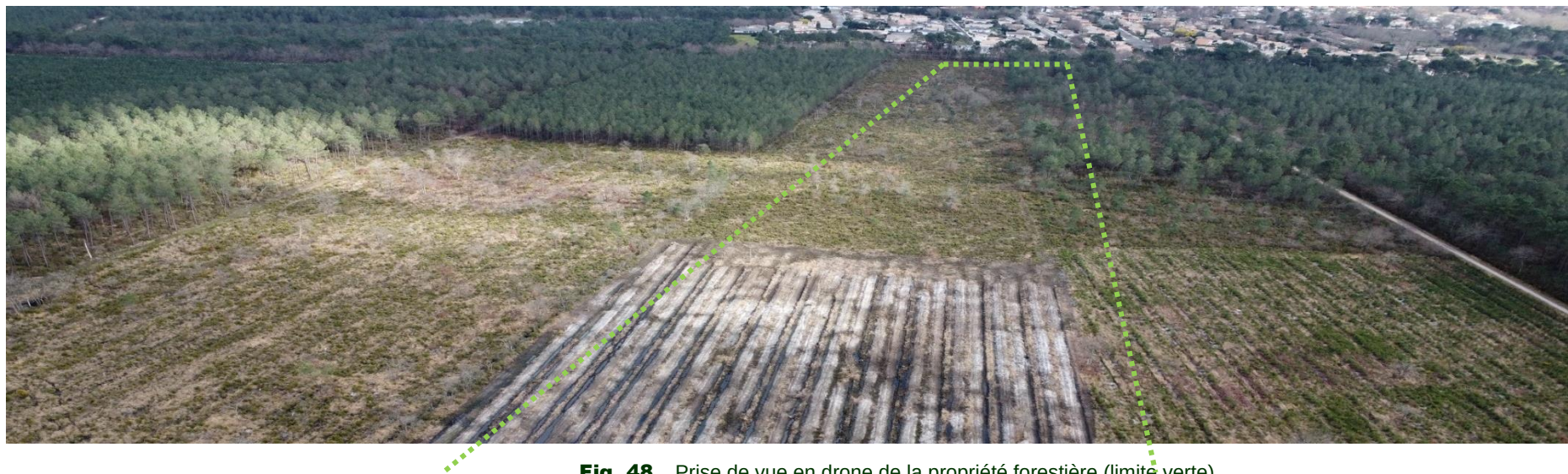
Fig. 48. Prise de vue en drone de la propriété forestière (limite verte)
