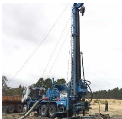
machine de forage
