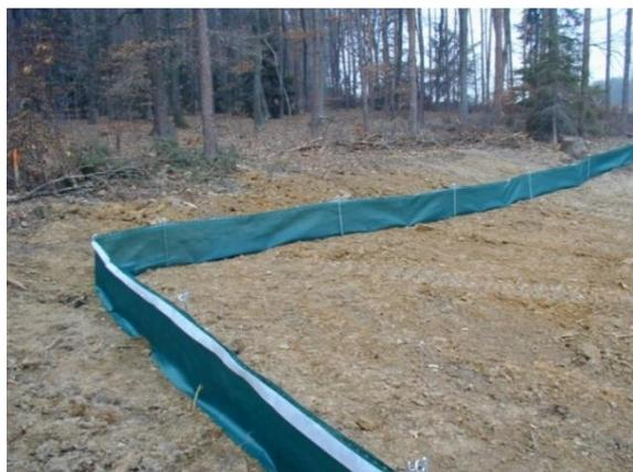
**Figure n°3. Linéaire de pose de la barrière anti-retour prévue**
