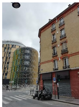
4- Immeuble de Faubourg aux angles Villeneuve et Boisseau
