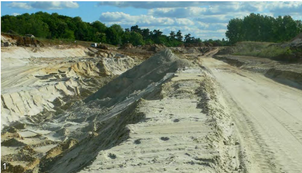
1. Sols remaniés à l'occasion des travaux de mise à quatre voies de la R.N.2 et de la réalisation des giratoires, à son intersection avec la route de Crépy. Les couches de sable sont affleurantes.
