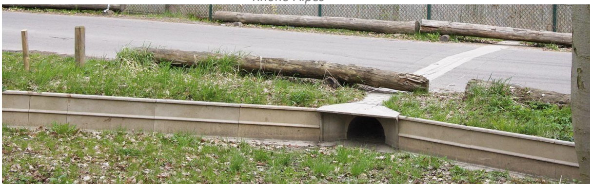
Exemple de passage faune (crapauduc) sous voirie – Source : ACO
