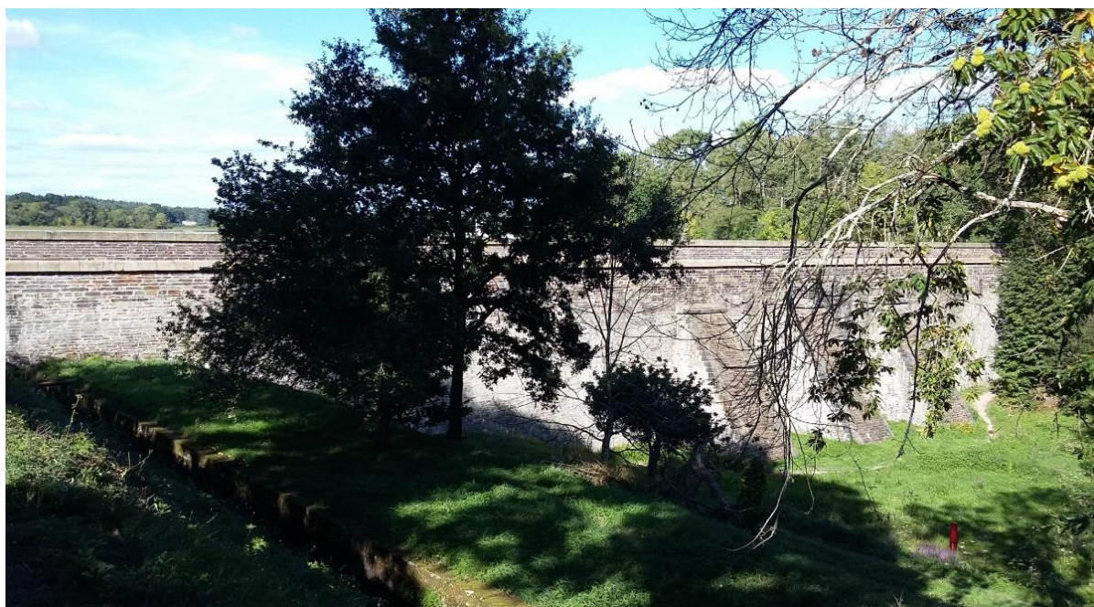
Vue sur le parement aval du Grand Vioreau
