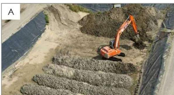
Figure 15 : Bassin de ressuyage gravitaire
