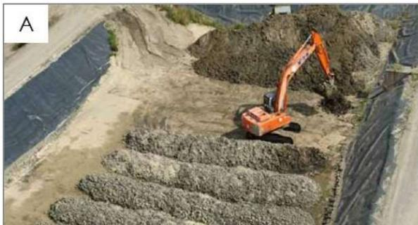
*Figure 37 : Bassin de ressuyage gravitaire*
