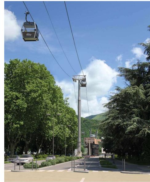
La hauteur de ces pylônes est variable tout au long du tracé en fonction des obstacles à franchir. Elle est comprise entre 21,6 et 40,7 m.
