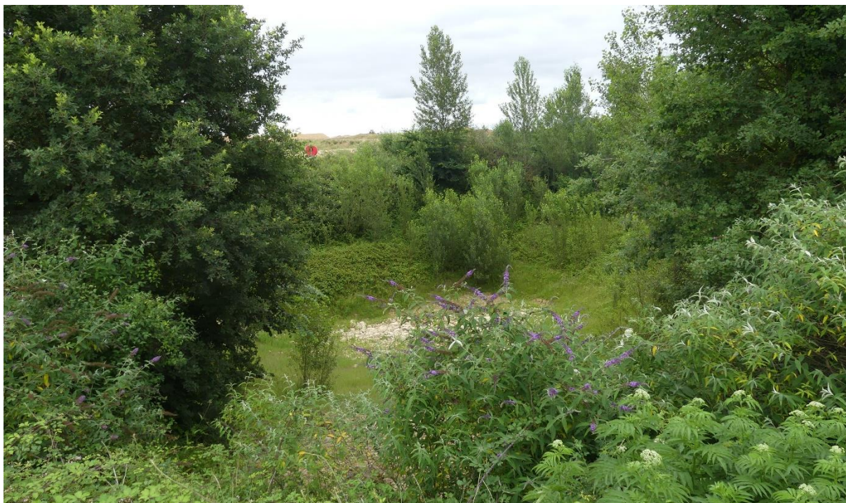
Bassin actuel (à sec) en aval du talweg guerre avec bouée (en arrière-plan)
