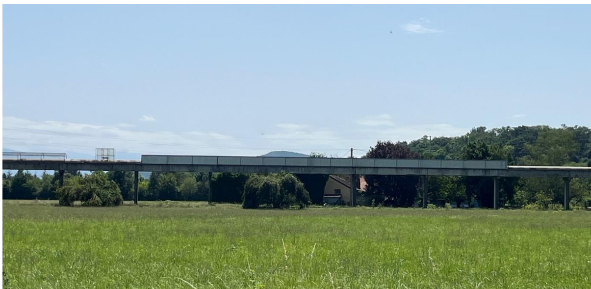
Bande transporteuse au sein d'un tunnel au droit d'habitations
