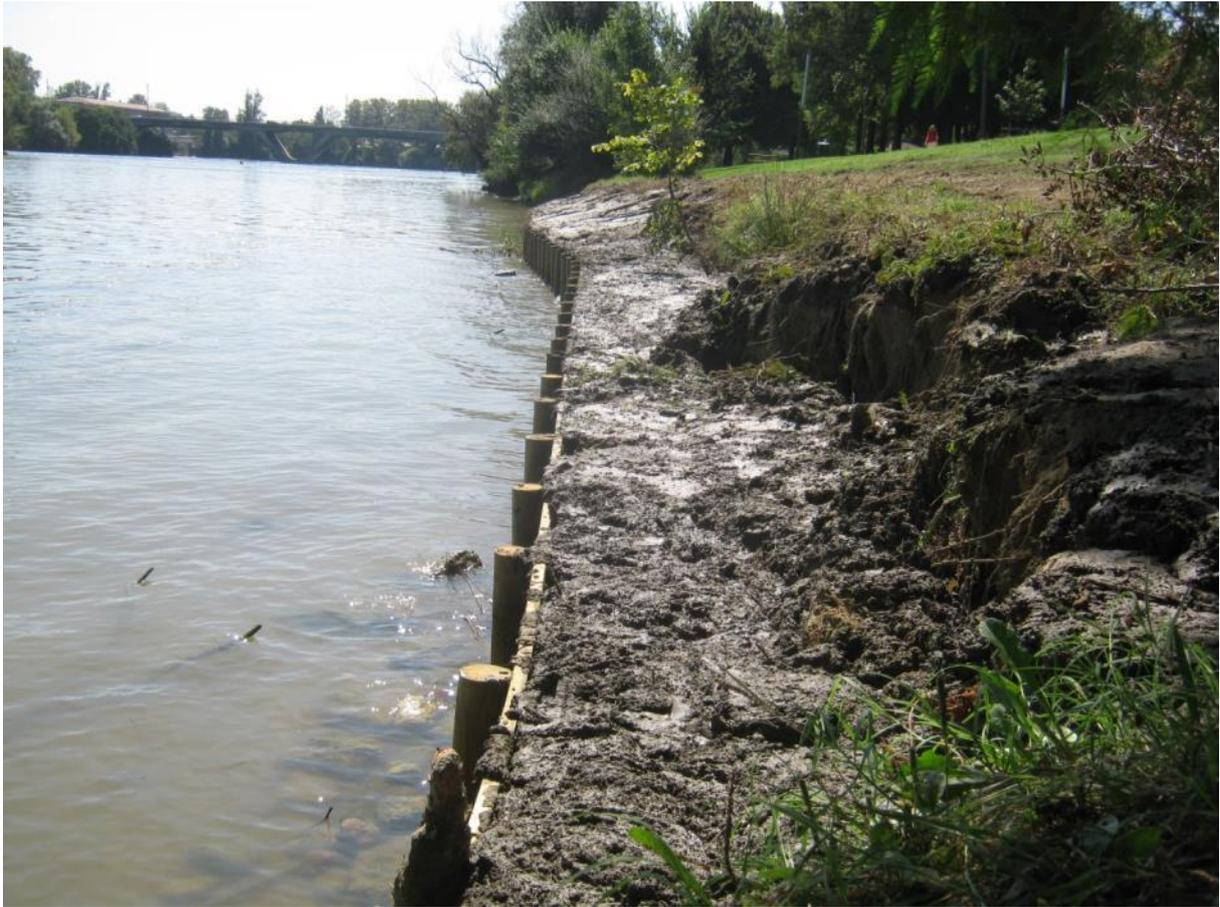
**Figure 4 : Photographie des travaux de restauration de berge par génie écologique sur Toulouse Métropole à partir des vases extraites sur le canal du moulin en 2015 – Image Toulouse Métropole**
