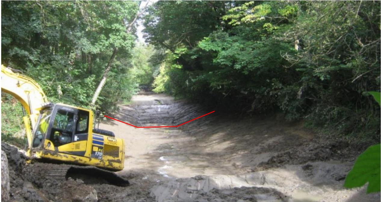
Figure 2 : Canal du moulin – Photographie des travaux de désenvasement de 2015 - Profil du désenvasement – Image Toulouse Métropole
