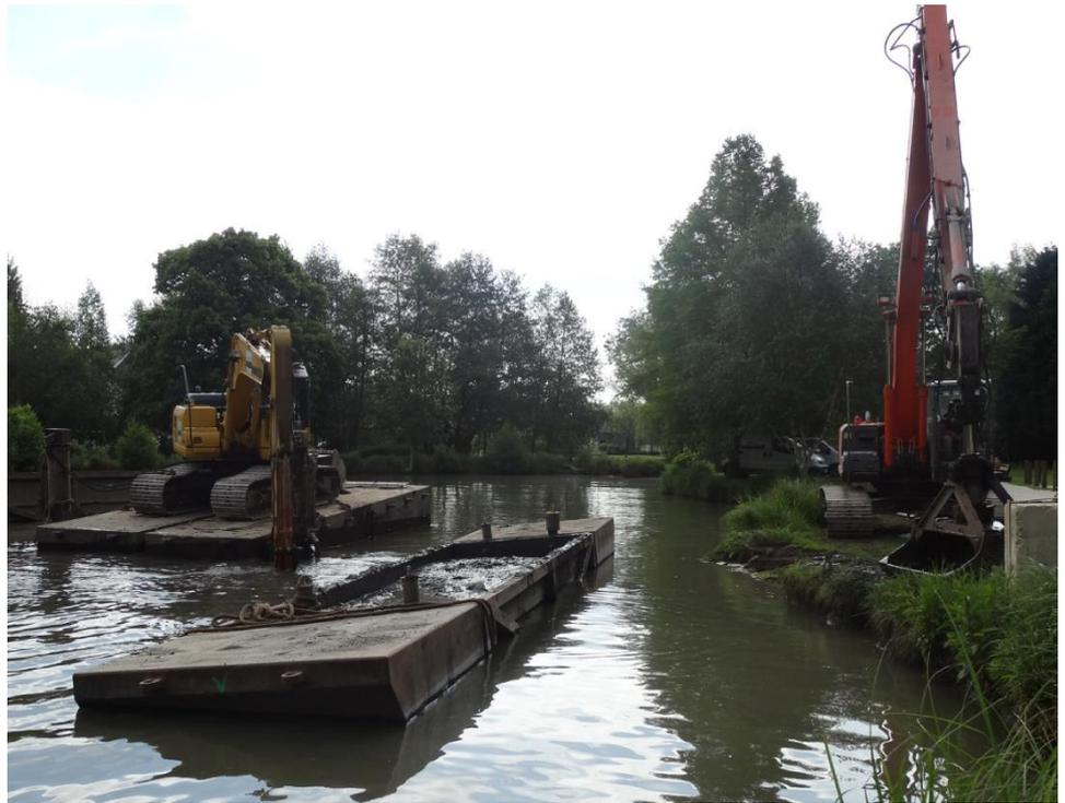
**Figure 51 : Exemple de pelle mécanique sur barge + barge flottante de stockage temporaire –**
