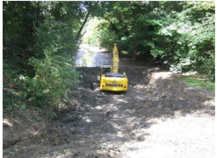
Figure 3 : Canal du moulin – Photographie des travaux de désenvasement de 2015 – Image Toulouse Métropole
