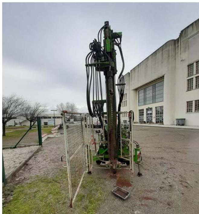
Figure 10 : Illustration du sondage Z07-D (parvis Nakache)
